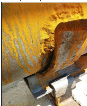
skica č.1 - původní kluzné uložení s objímkou
