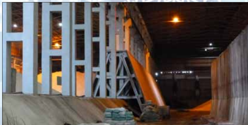
Nová dělicí stěna v hale superfosfátu.
