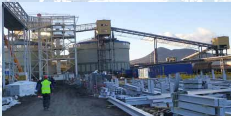
Nová přesypná věž a dopravníkové mosty.
