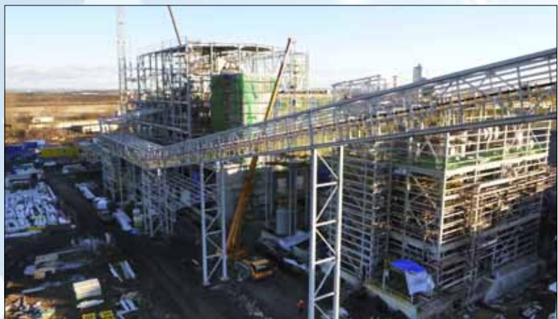
Pohled na staveniště UGL.
