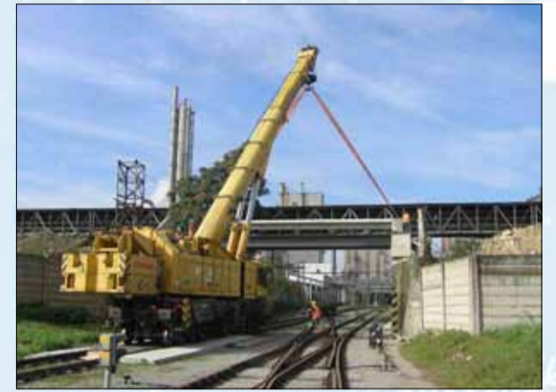
Montáž nových mostovek.
