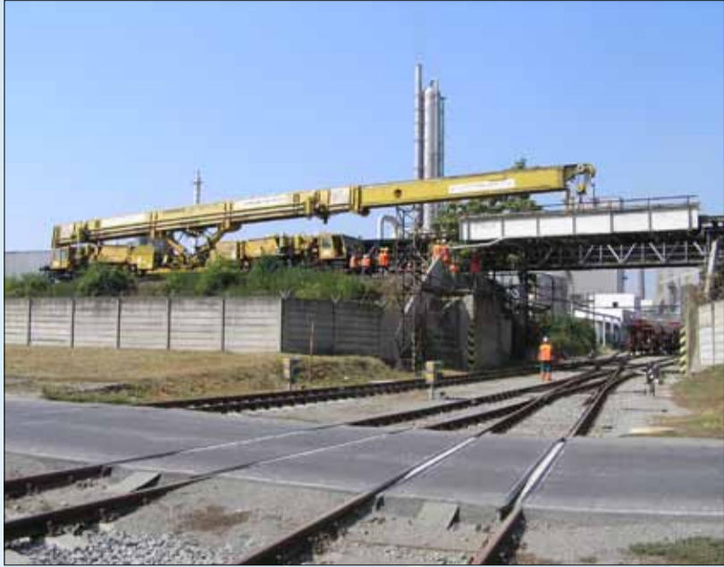
Železniční jeřáb v činnosti.
