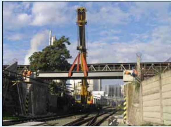
Montáž nových mostovek.
