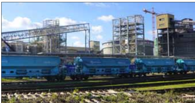
Nová přesypná věž a dopravníkový most.
