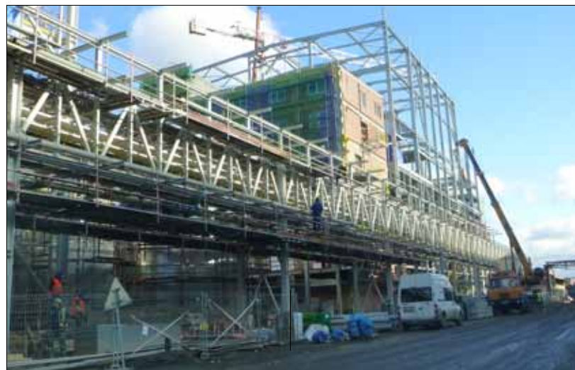
Pohled na staveniště UGL.
