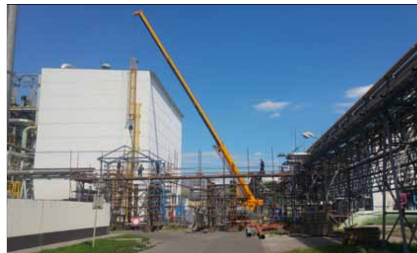
Oprava mostu S01.
