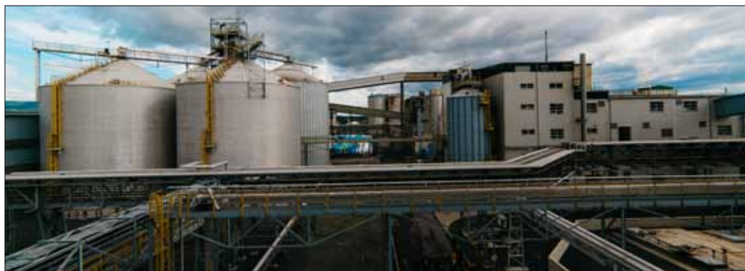
Výhled na budovu lisovny a sklady řepkových šrotů.
