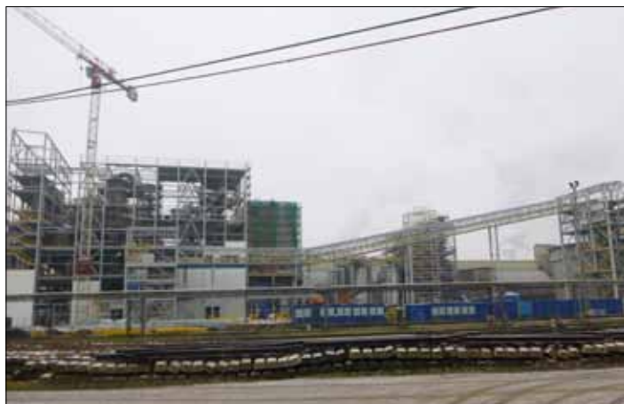
Pohled na staveniště UGL.
