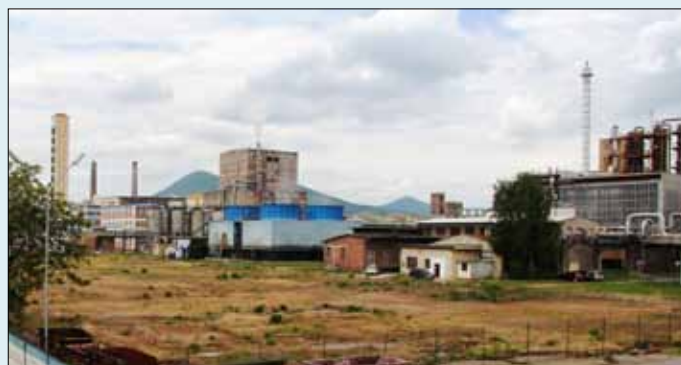
Uvolněný prostor po demolici výroben v roce 2003.
