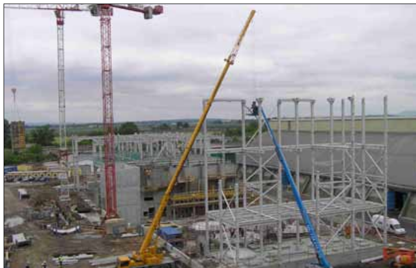
Celkový pohled na staveniště.
