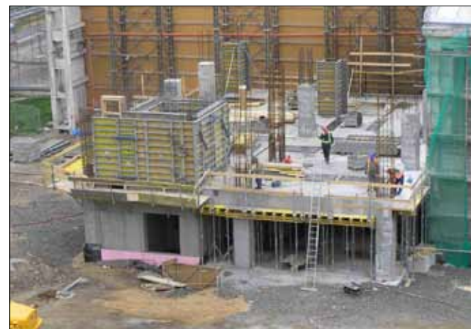
Rozestavěnost objektu logistiky.
