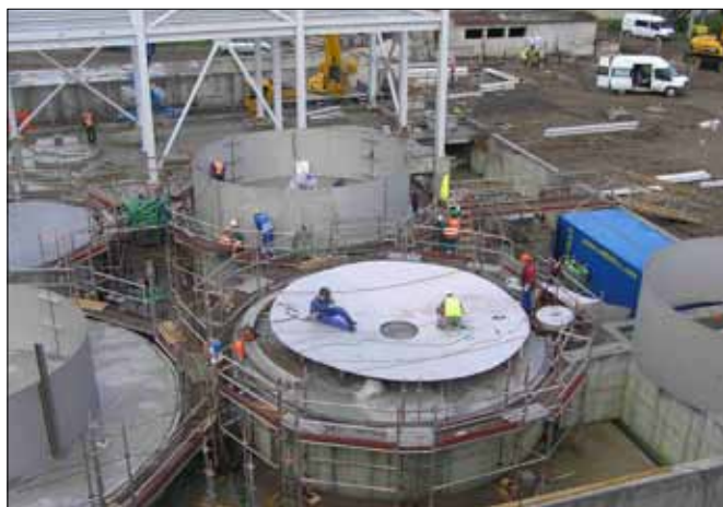
Základy budoucích zásobníků.
