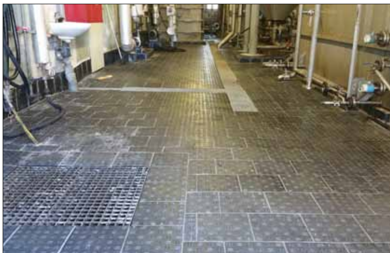
Podlaha v místnosti neutralizace po opravě.
