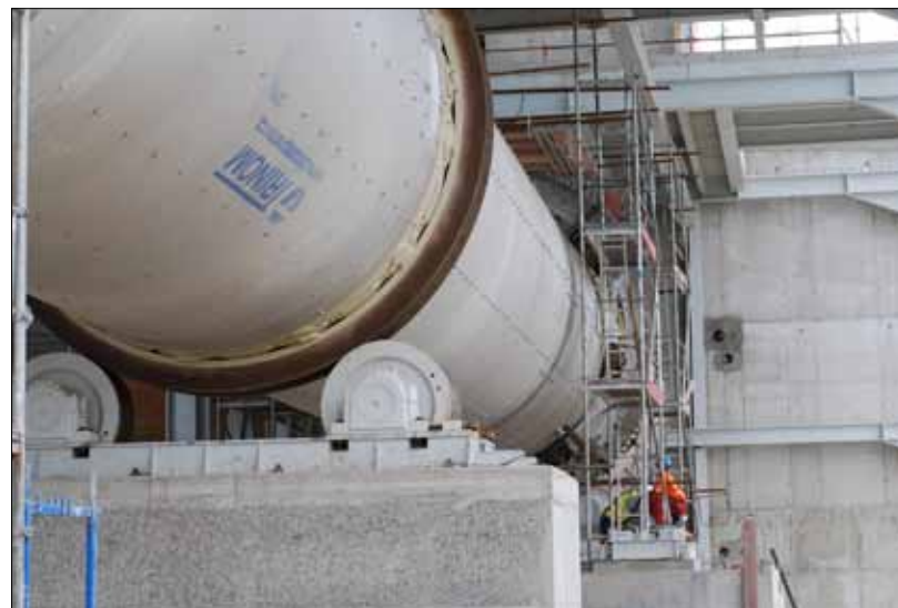
Práce na sušicím bubnu.
