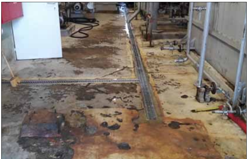
Původní podlaha v místnosti neutralizace.
