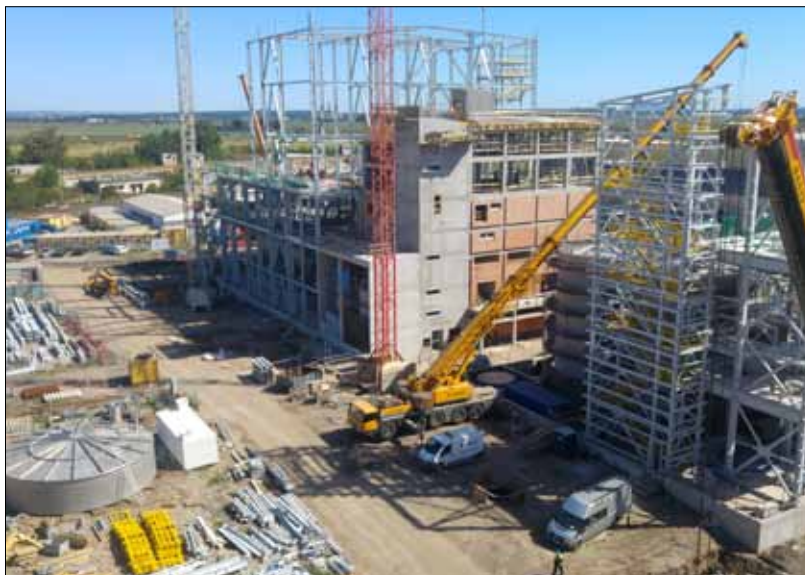
Celkový pohled na staveniště.
