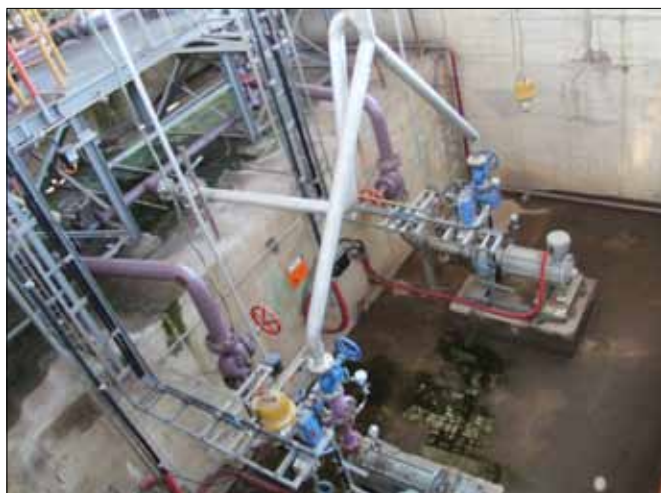
Čerpadla kapalného čpavku HERMETIC na stáčení
