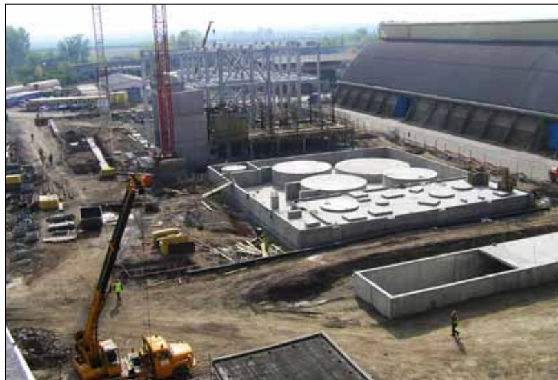
Celkový pohled na staveniště.
