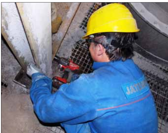
Pracovník JATEMONT při výměně spojovacího materiálu.
