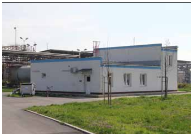
Budova velínu stáčení a skladování čpavku
