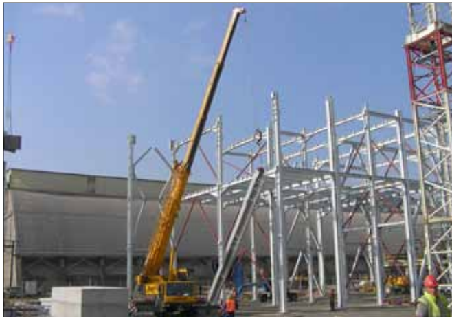
Ocelová konstrukce objektu UGL.
