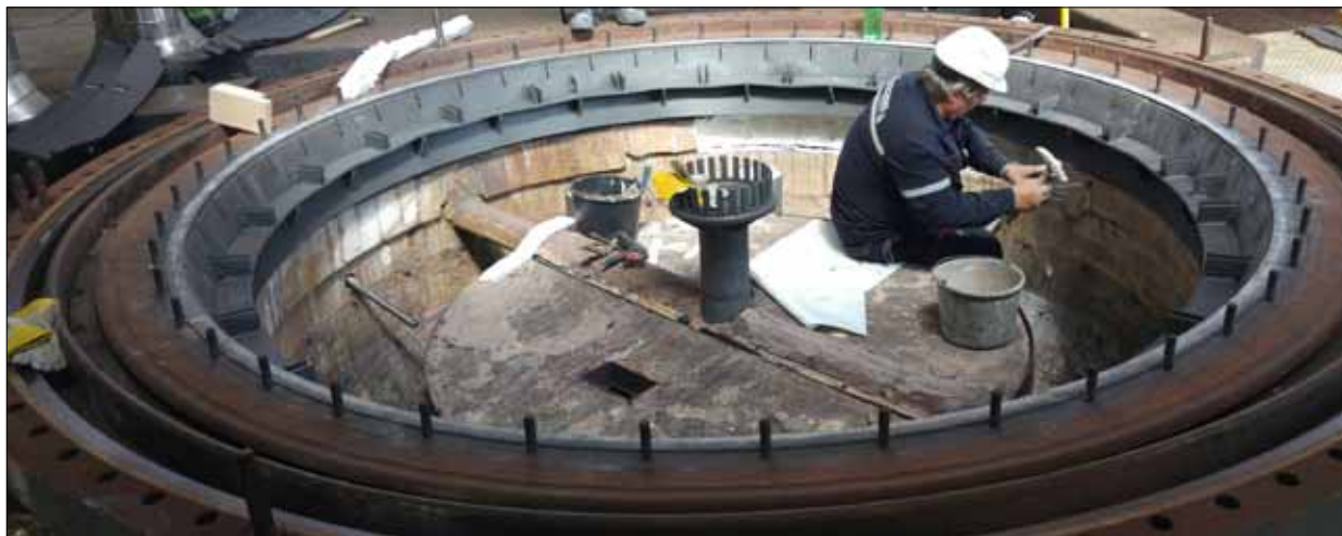
Oprava vyzdívky kotle výroby kyseliny dusičné KD5.
