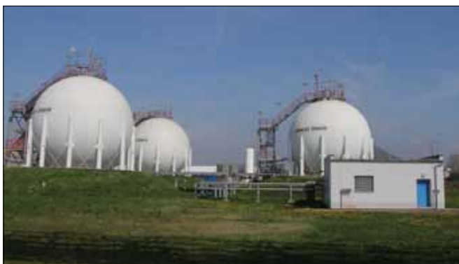
Zásobníky kapalného čpavku, budova skrápěcího zařízení pro vytvoření vodní clony
