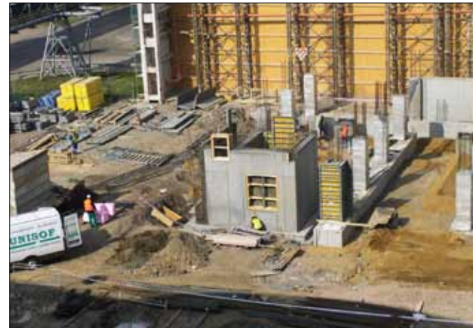
Rozestavěnost objektu logistiky.
