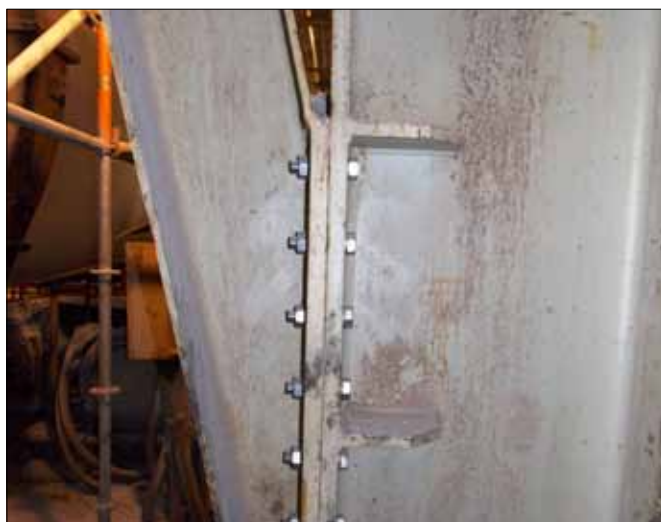
Konstrukční spoj po výměně spojovacího materiálu.
