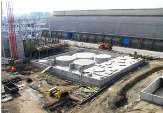
Základy budoucích zásobníků.
