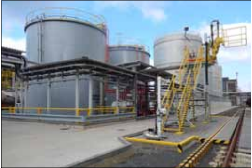
Pohled na sklad KS z jihozápadu. Před zásobníky je čerpadlovna a stáčení železničních cisteren.
