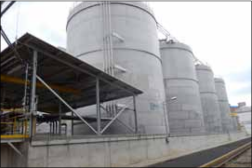
Pohled na sklad KD ze severovýchodu, vlevo je čerpadlovna.
