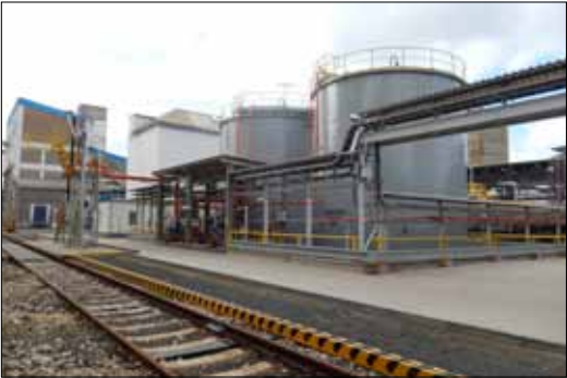
Pohled na sklad KS z jihovýchodu. Před zásobníky je čerpadlovna a stáčení železničních cisteren.
