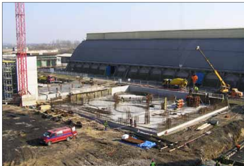
Celkový pohled na staveniště.
