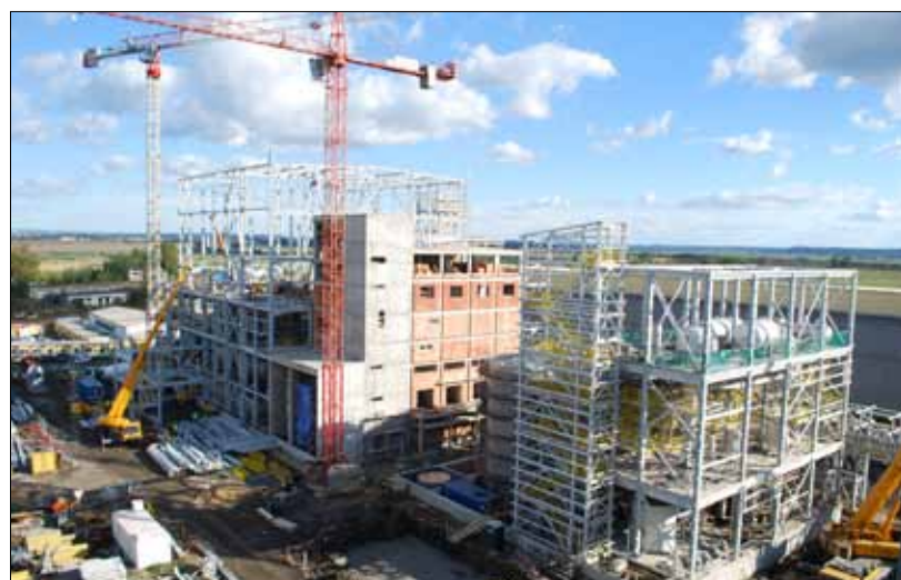
Celkový pohled na staveniště.
