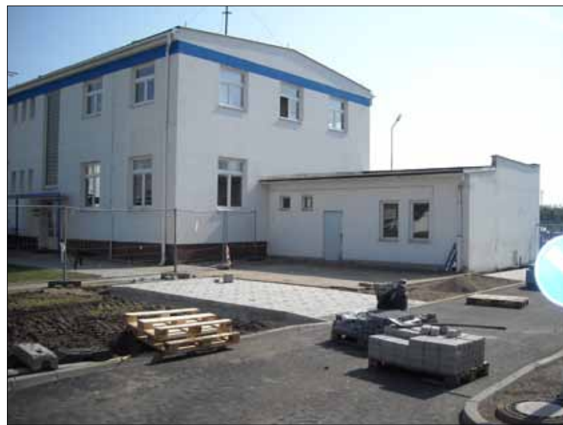
Umístění firemní prodejny bude v budově obchodního úseku. Foto: Josef Schwammburger
