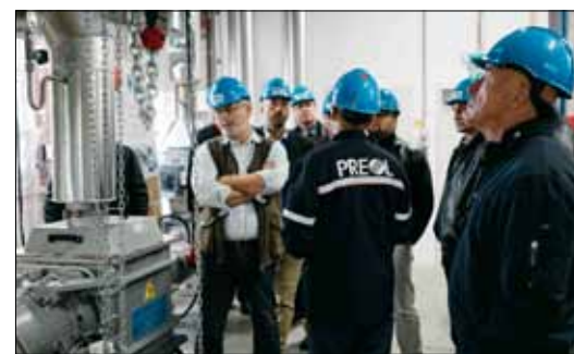
Prohlídka s výkladem od vedoucího provozu extruze, uvnitř technologie.
