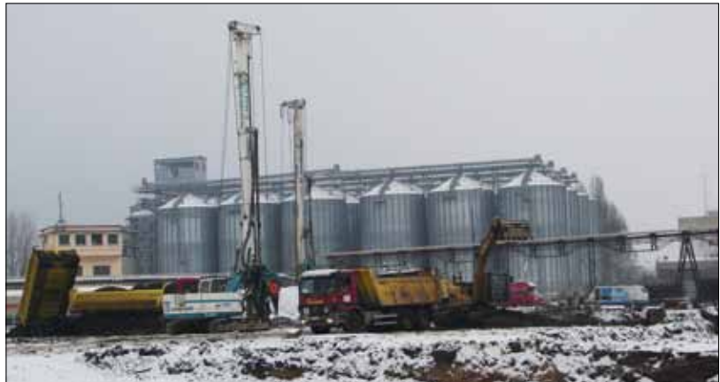
Práce na staveništi na začátku ledna.
