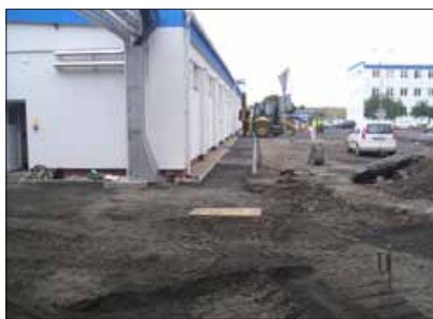
Oprava ploch před novým archivem.
