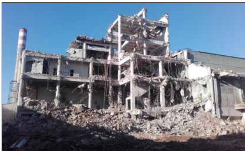
Demolice objektu granulace superfosfátu.
