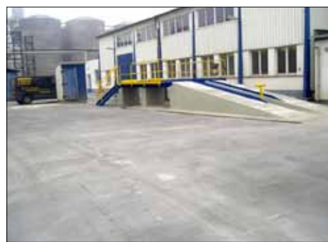
Dokončená oprava betonových ploch u Autodopravy.
