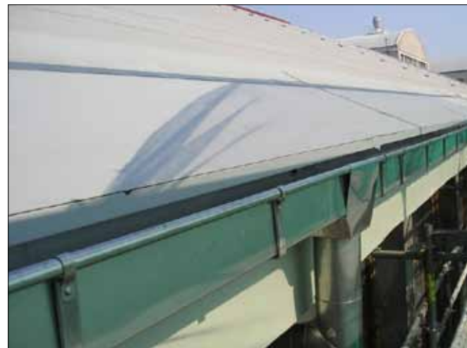
Střecha haly C v GSH - dokončená oprava - detail.
