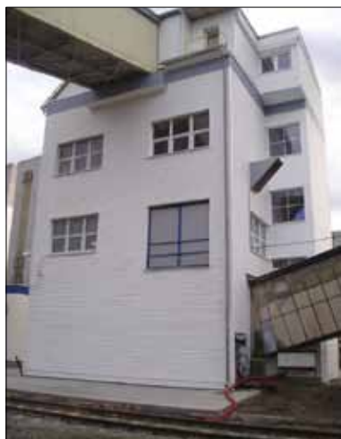
Budova Drtírny vápence po opravě.
