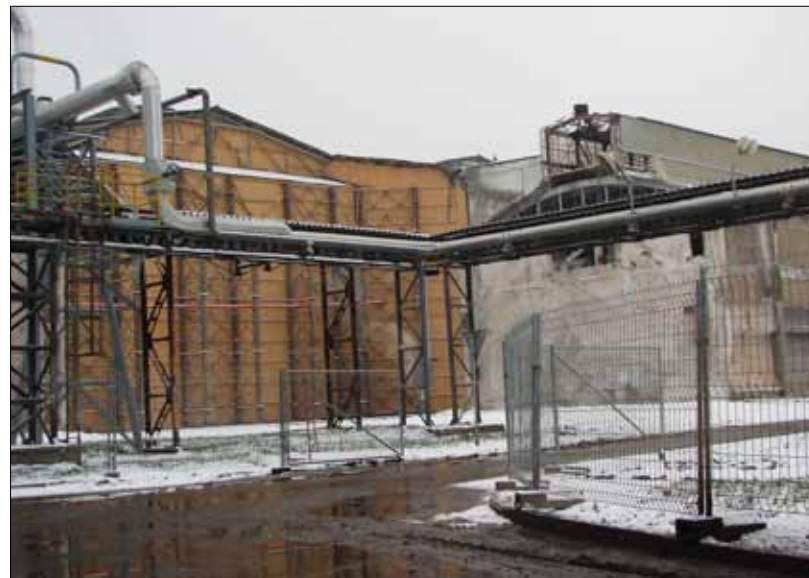
Výbouraná část haly zrání (bývalý superfosfát).
