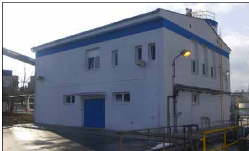
Výrobní vápenného mléka po opravě.
