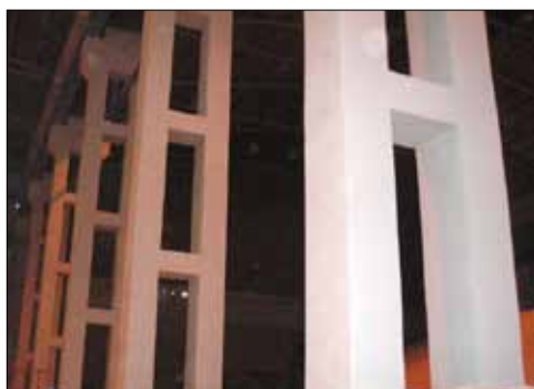
Středové pilíře skladovací haly po opravě.
