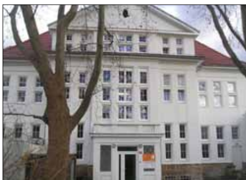
Budova Zdravotního střediska po opravě fasády a oken.
