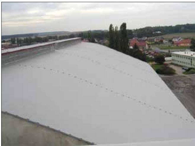
Střecha haly C v GSH - dokončená oprava.
