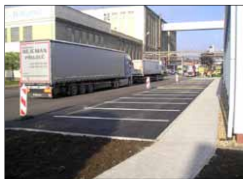
Dokončená oprava ploch před novým archivem.
