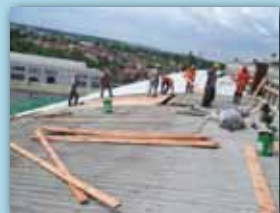
HLAVNÍ STAVEBNÍ OPRAVY PROVEDENÉ V ROCE 2015
