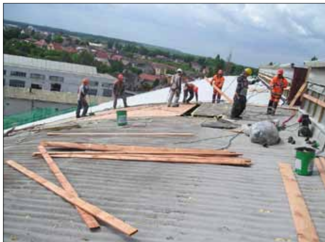
Střecha haly C v GSH - demontáž krytin.
