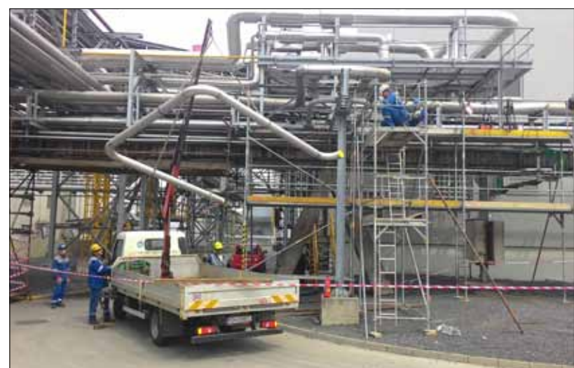
Montáž jednoho z kompenzátorů potrubí MAKS-D.
