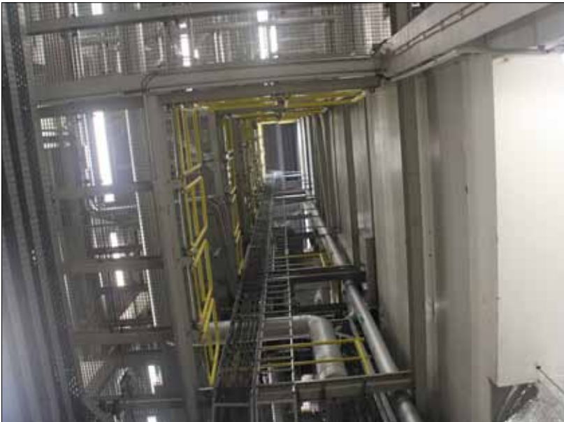
Pohled montážním otvorem z podlahy na strop v 32,9 m.
