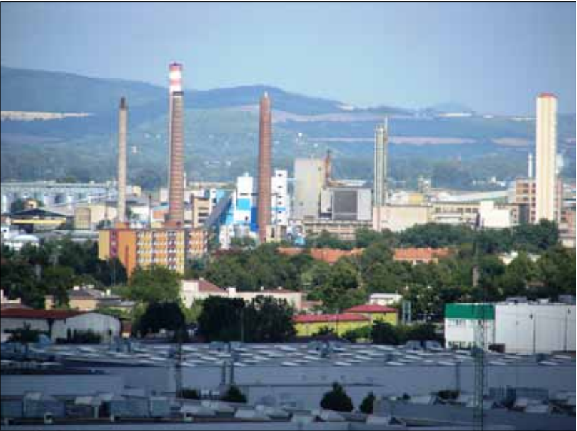
Objekt energetiky, pohled z Lovosic.
