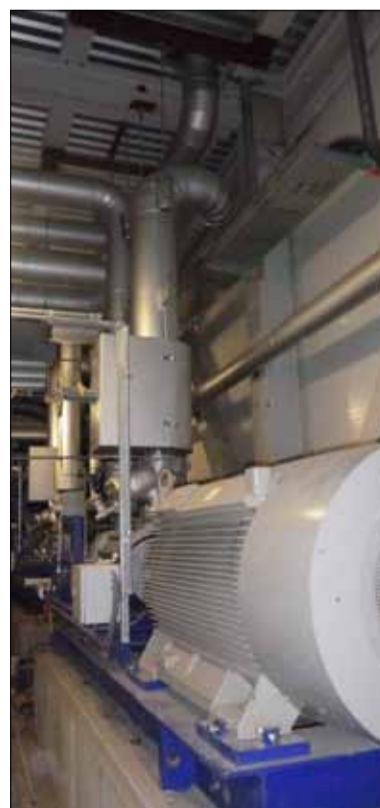
Napájecí čerpadla.
