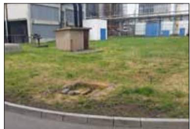
Nezajištěná šachta → nebezpečí propadnutí.
