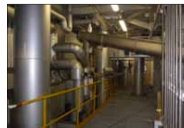
Technologie v nové kotelně.
