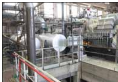
Dokončování rozvodů ve strojovně.
