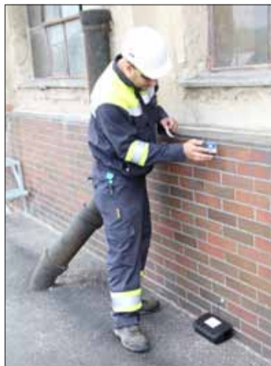
Během dubna instalovala firma Atalian venkovní deratizační boxy podél budov v areálu Lovochemie. Foto: Eva Živná
