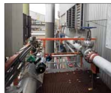
Předchozí zářezkové práce na LAV3.
