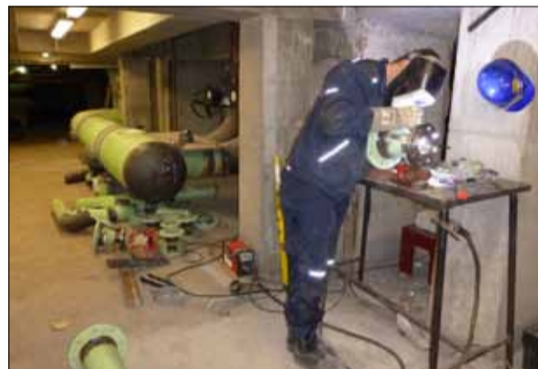
Svařování potrubí pro turbínu TG7.
