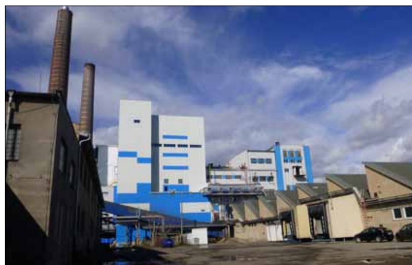
Objekt energetiky po dokončení.
