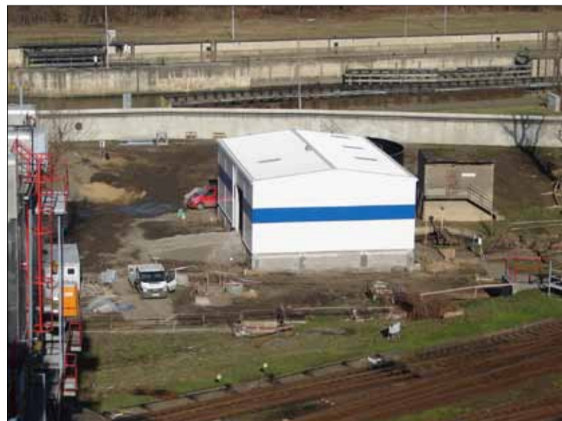
Pohled na staveniště nové MBČ.
