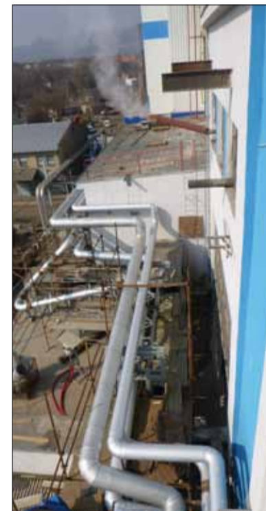
Nové parovody z kotelny.
