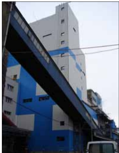
Celkový pohled na kotelnu K8.
