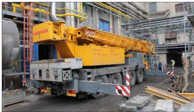
Zdvihací práce na energetice.
