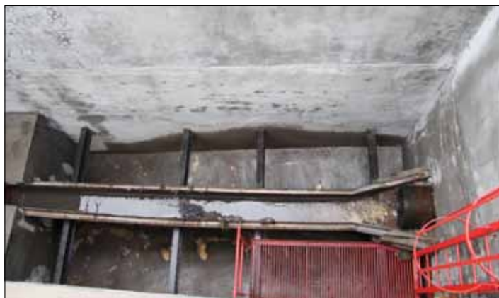
Žlab, kde se stékají veškeré splaškové vody.
