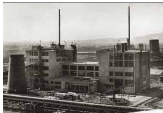
Pohled na výstavbu výroby NPK hnojiv.
