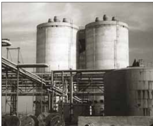
Granulační věže výroby LV, zásobník TDV.
