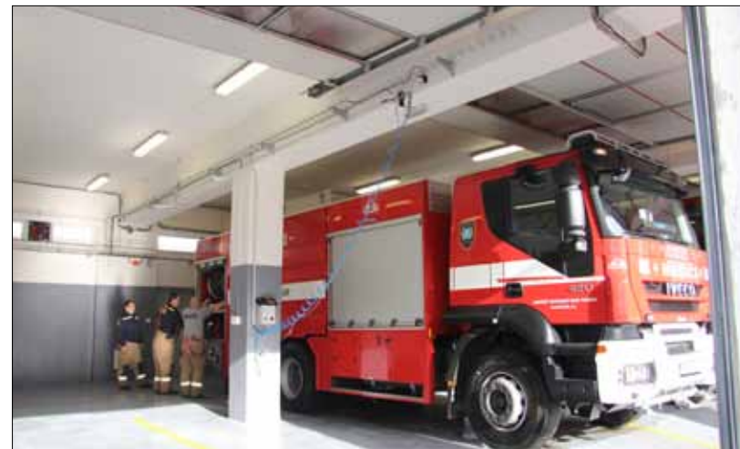
Garáže HZSP po rekonstrukci.
