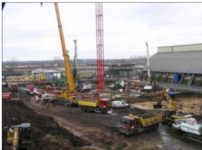
Celkový pohled na staveniště.
