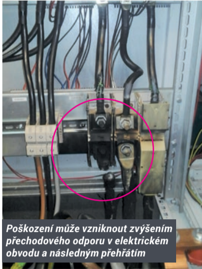
Poškození motorového vývodu pro čerpadlo P2405C na provozu UGL
