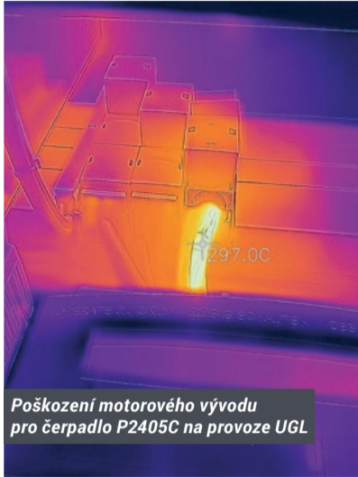
Poškození může vzniknout zvýšením přechodového odporu v elektrickém obvodu a následným přehřátím
