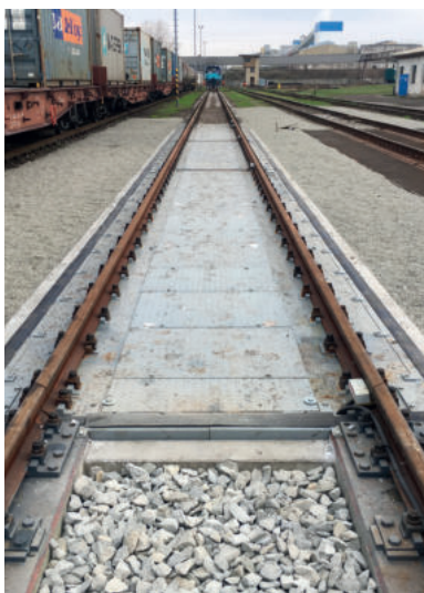
Nová kolejová váha usnadní práci na vlečce podniku
