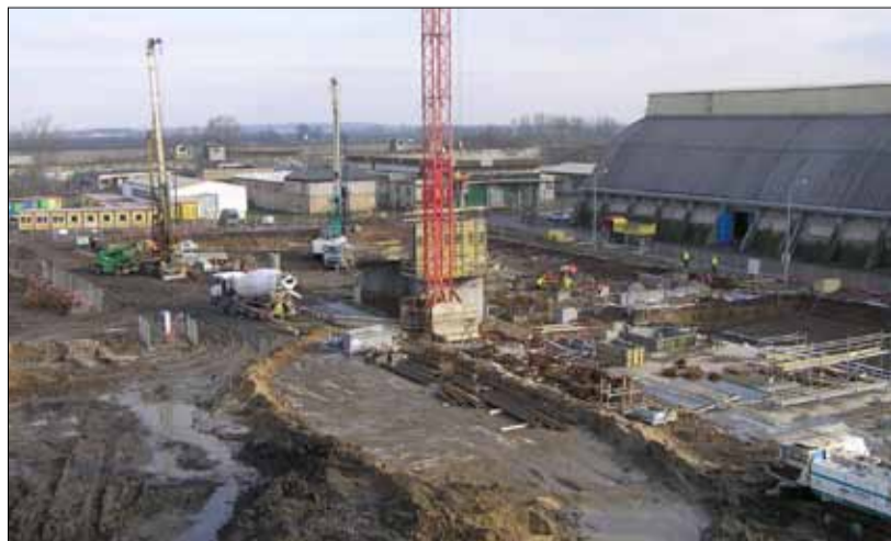
Celkový pohled na staveniště.
