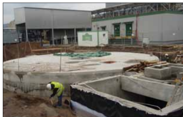
Základ pro sklad Extrudovaného řepkového šrotu.
