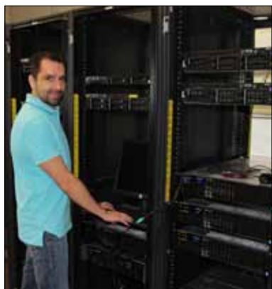
Nové zařízení serverovny.
