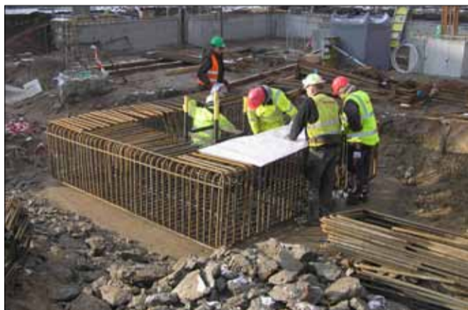
Armování základových konstrukcí.
