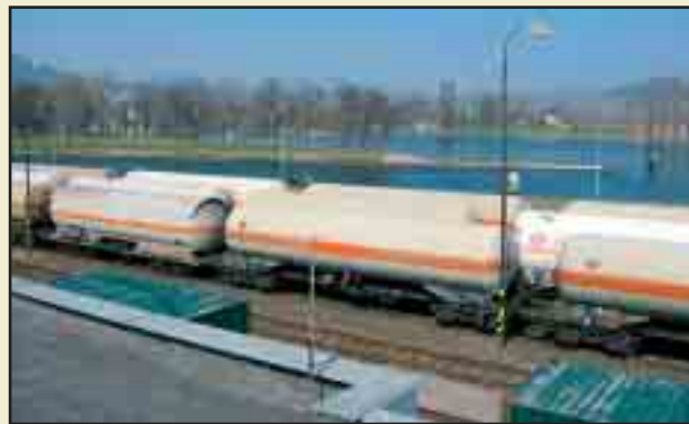
Železniční vlečka umožňuje dopravu základních surovin do areálu Lovochemie.
