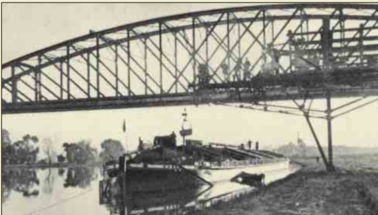
Z přístavu u železničního mostu se lanovou drahou navázely do továrny suroviny a zpět do lodí se expedovala vyrobená hnojiva.
