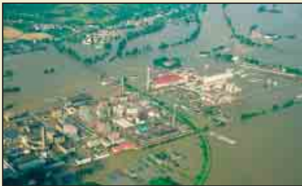
Letecký pohled na zcela zaplavený areál Lovochemie během kulminace hladiny rozvodněné řeky Labe dne 16. 8. 2002
