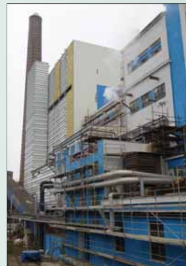
Zateplování objektu kotelny.
