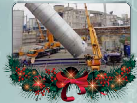
INSTALACE NÁDRŽÍ NA PREOL FOOD strana 2
