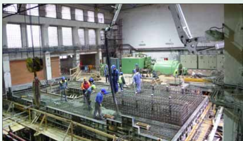
Betonování základu turbogenerátoru.
