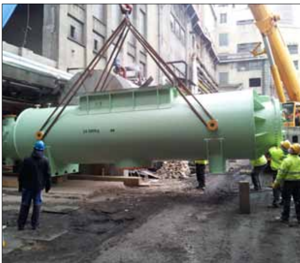
Obr. 3 Instalace kondenzátoru turbíny TG7.
