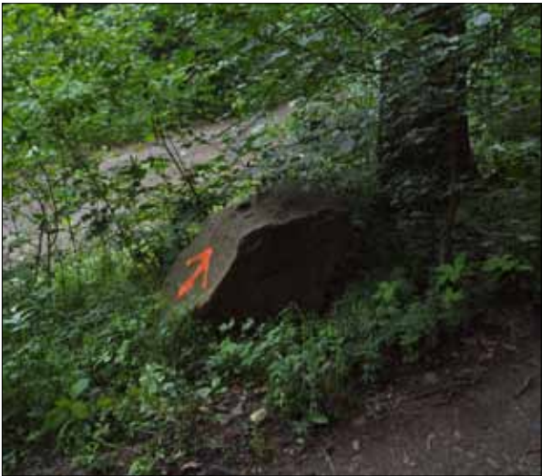
Původní stav kamene před opravou.
