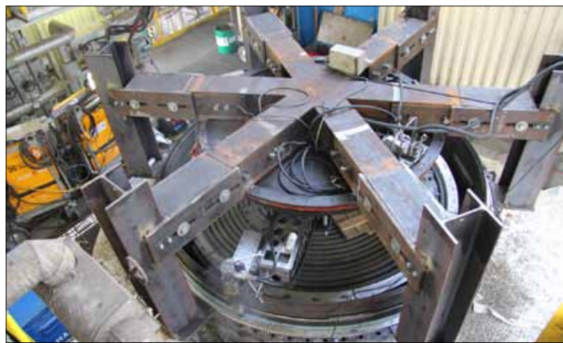
Stroj na úpravu drážky konvertoru KD6 v činnosti.
