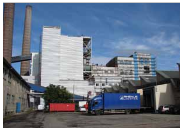
Obr. 2 Instalace střechy a opláštění kotelny.
