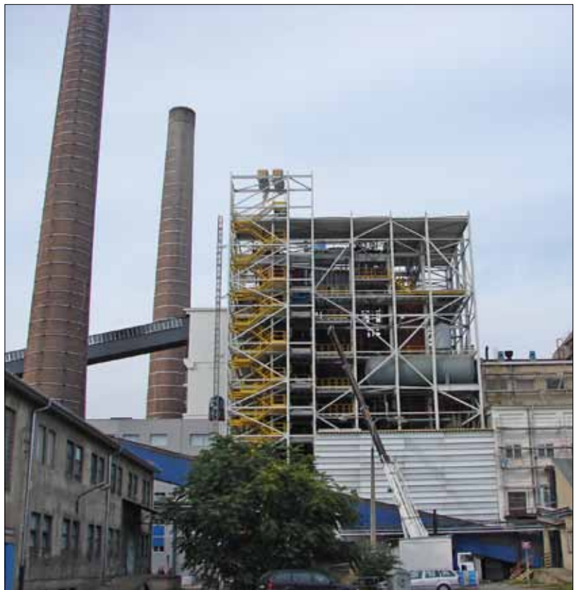
Instalace střechy a opláštění kotleny.
