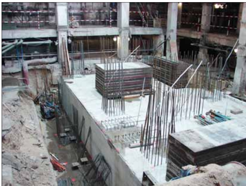
Výbetonovaná spodní část základu nové turbíny.
