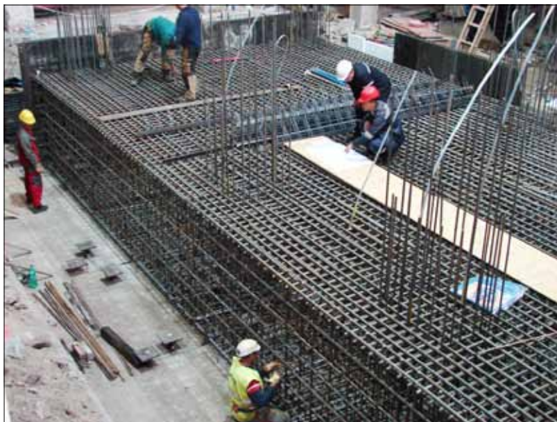
Realizace výztuže základu turbíny (spodní hrana v úrovni -4,5 m pod terénem).
