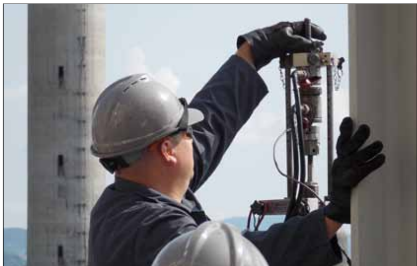
Montáž zkušebního zařízení na pojistný ventil.
