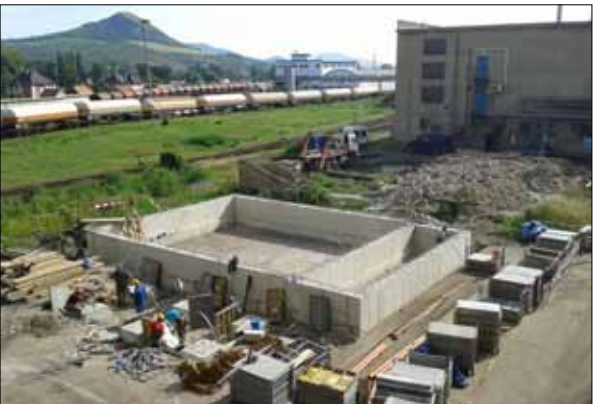
Výstavba kompresorové stanice, v pozadí nové potrubí chladič vody.
