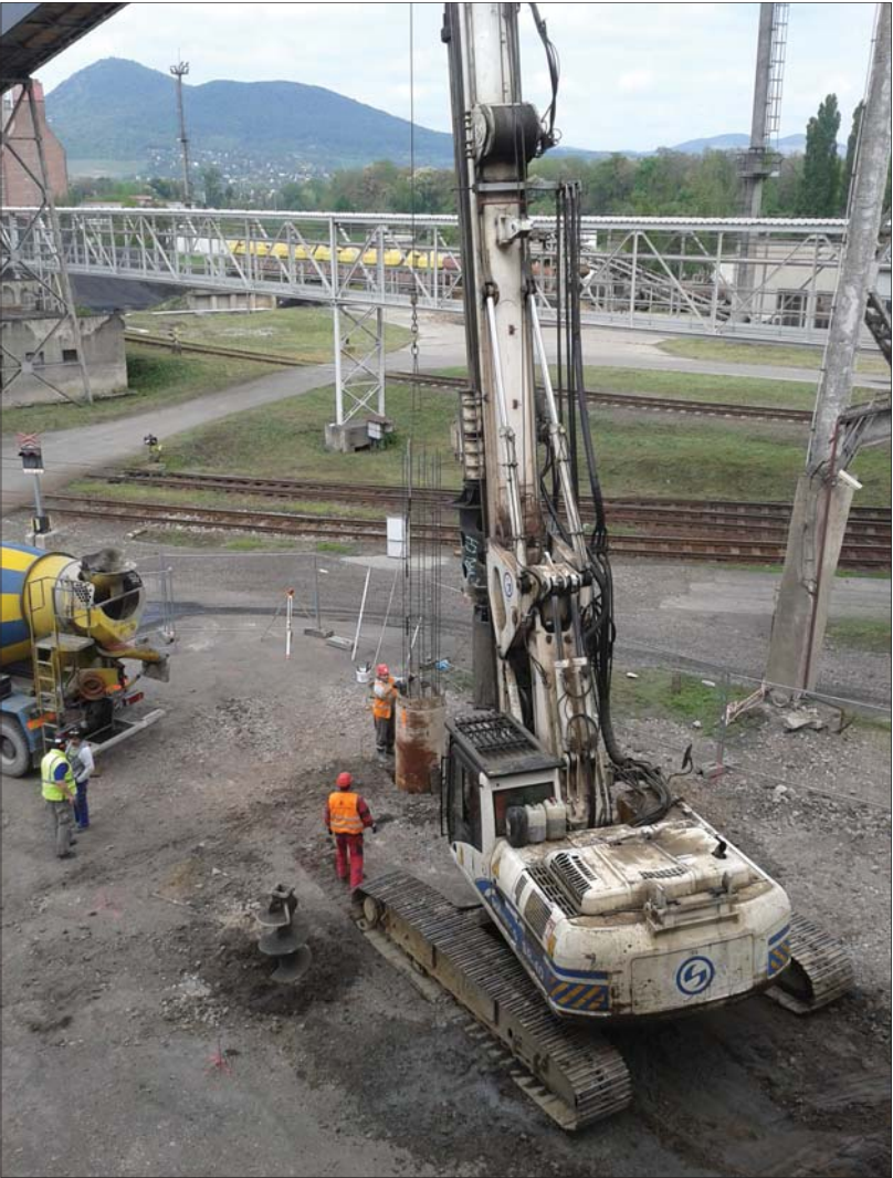
Obr. 2 - Pilotáž základů spalínového ventilátoru.
