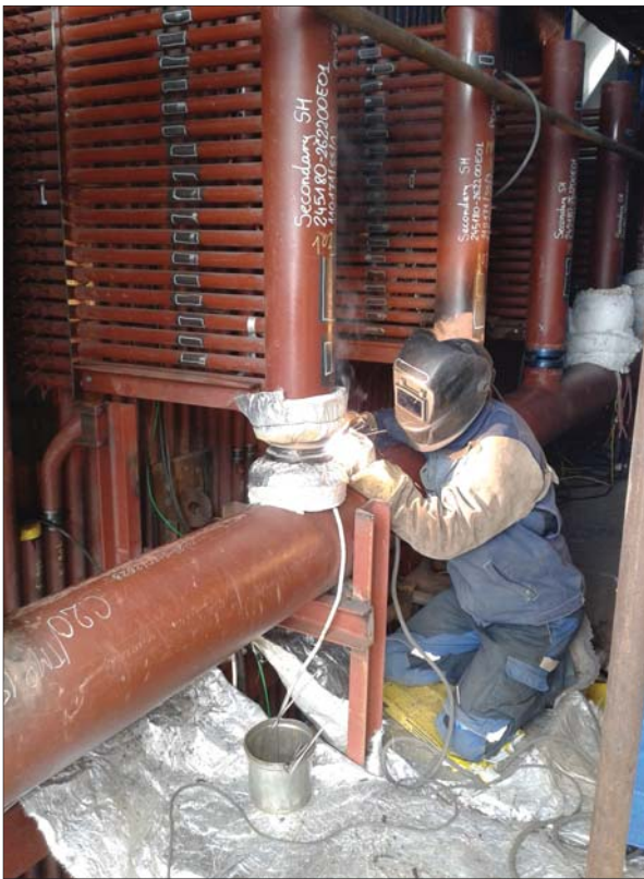
Obr. 4 - Svařování parních rozvodů.
