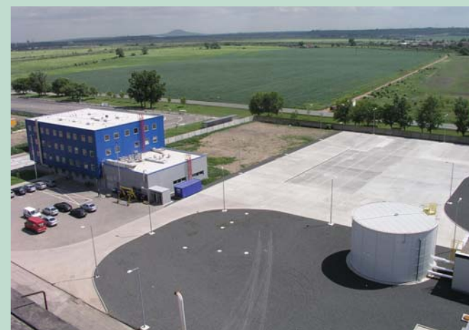
Na ploše jižně od NPK, vedle nádrže požární vody se pět let po slavnostním otevření rozjely stavební práce výstavby rafinérie jedlých olejů dceřiné společnosti PREOL FOOD, a.s. Tento rozvojový projekt načas novou pětiletku v historii společnosti PREOL, a.s.
