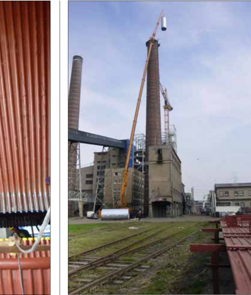
Obr. 4. Usazování komínové vložky.
