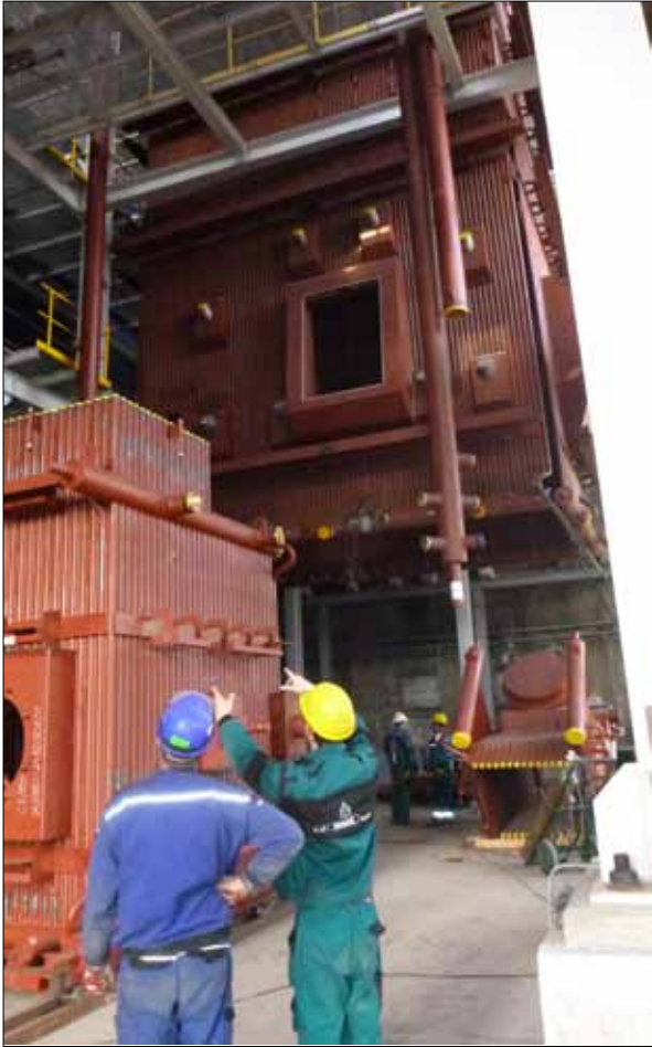
Usazování stěn kotle.
