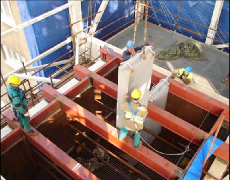
Instalace předehřívače vzduchu.
