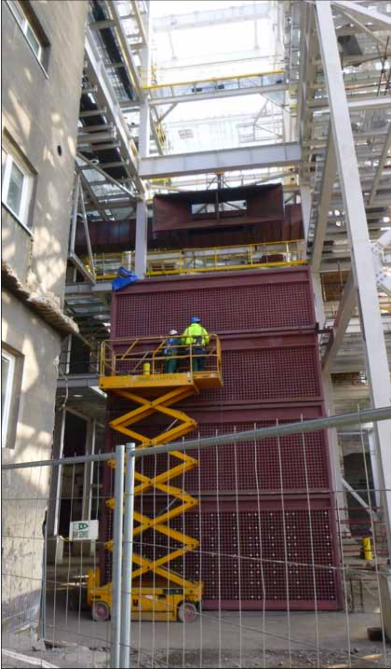
Práce na ohříváku vzduchu.
