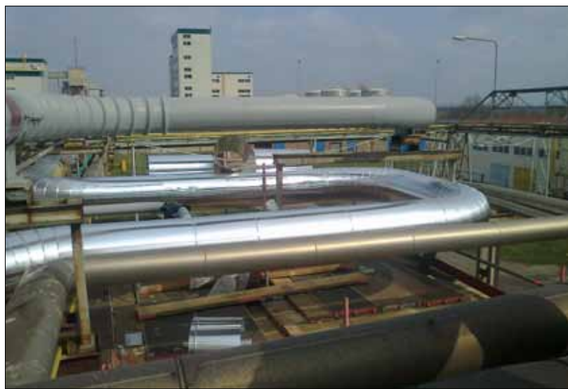
Parovod v novém kabátě.
