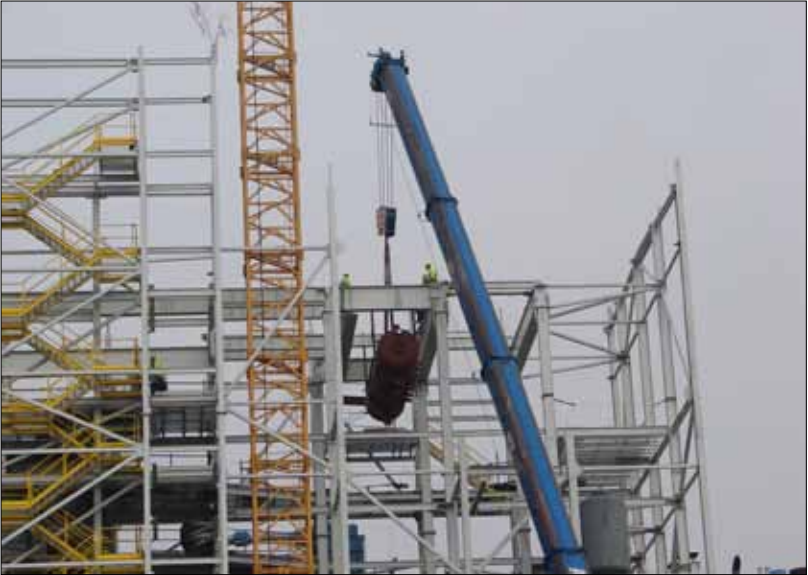
Instalace parního bubnu na +35 m.
