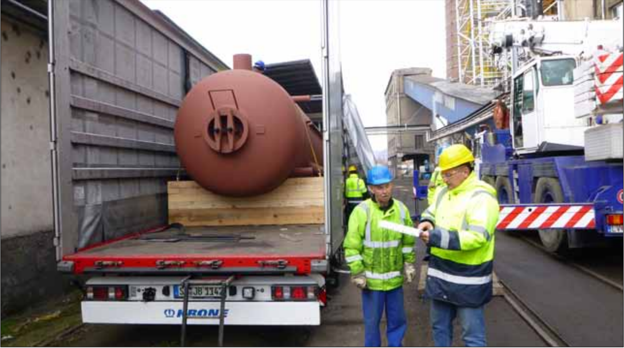
Přejímka parního bubnu montážní firmou.
