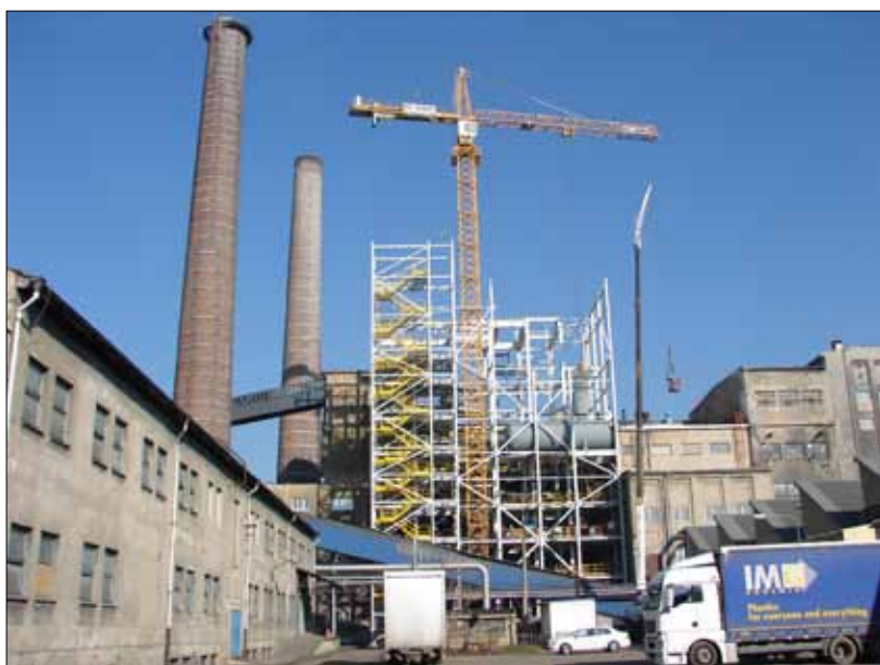
Celkový pohled na stavbu kotelny.
