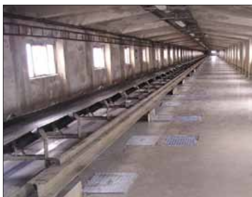
Dokončená oprava podlahy.
