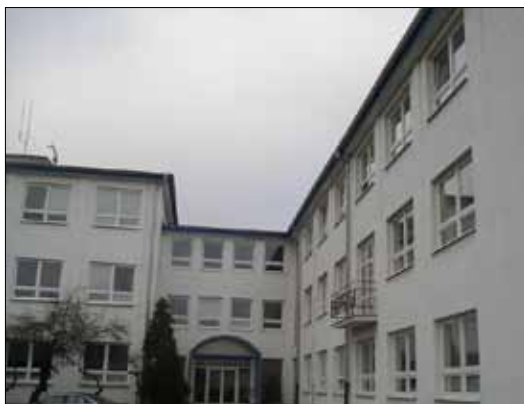
Administrativní budova GR - po opravě oken.
