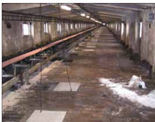
Chodba v lucerně Paraboly LAV - původní podlaha.
