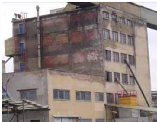
Expedice NPK+LV stav před opravou.
