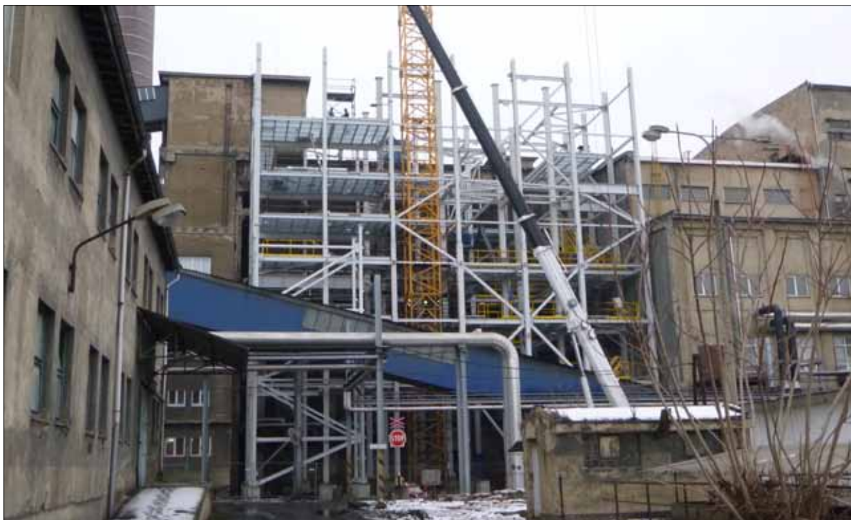
Celkový pohled na stavbu kotelny.
