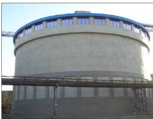
Kruhový sklad KCL - stav po opravě.
