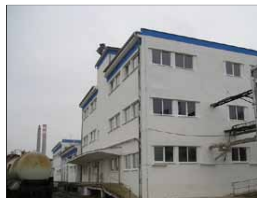
Úprava vody - po opravě.
