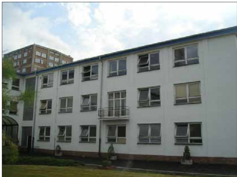
Administrativní budova GR - před opravou oken.
