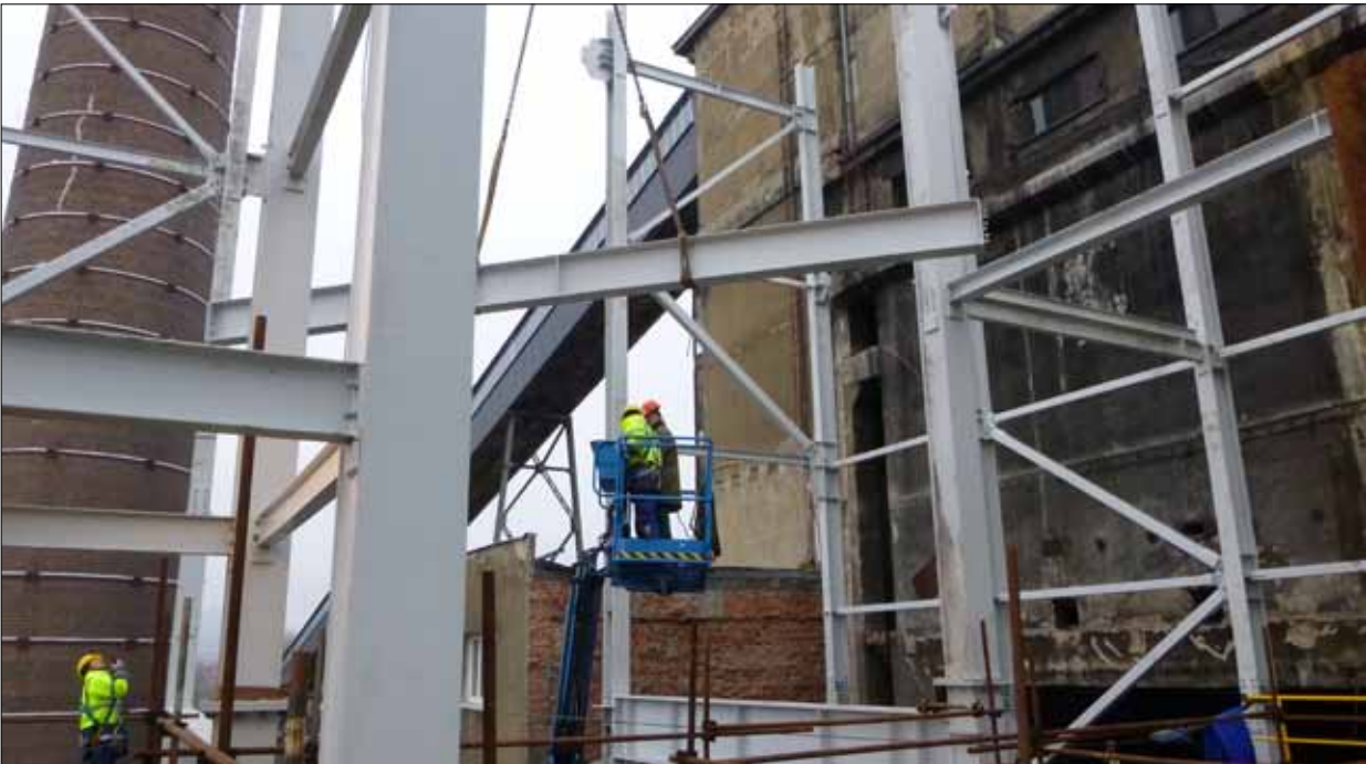
Práce na usazování nosníků.
