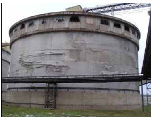
Kruhový sklad KCL - stav před opravou.
