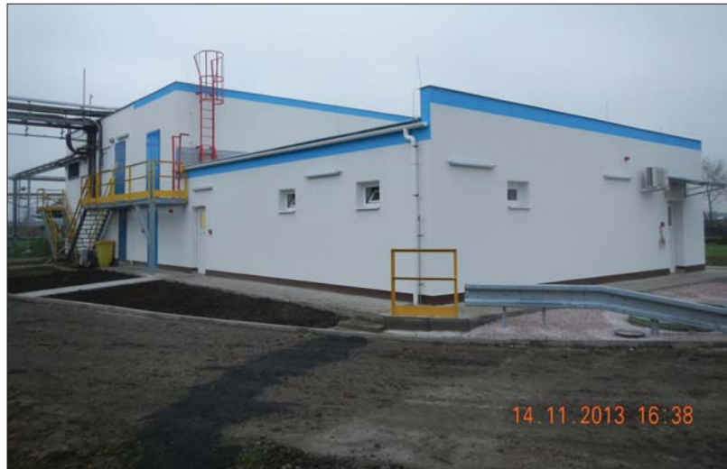
Nový velín a rozvodny.
