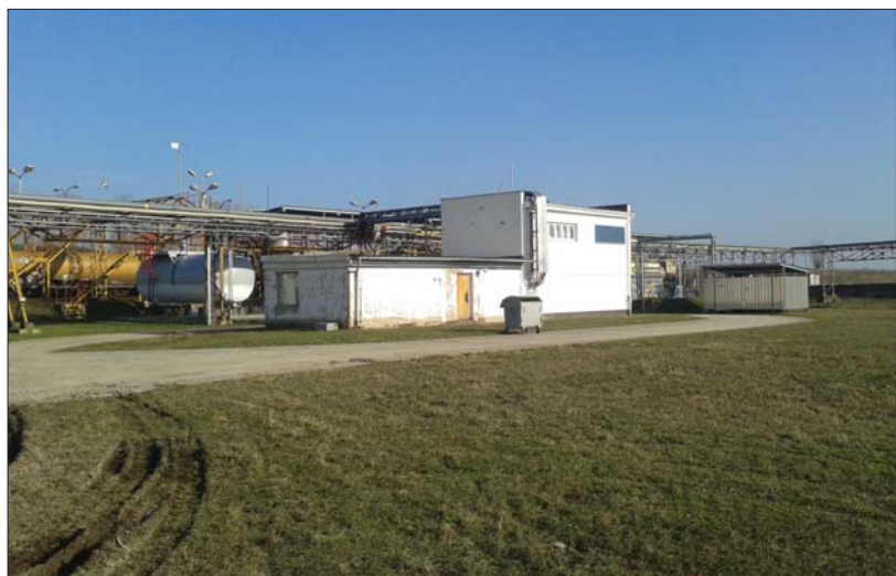
Starý velín s rozvodnou.
