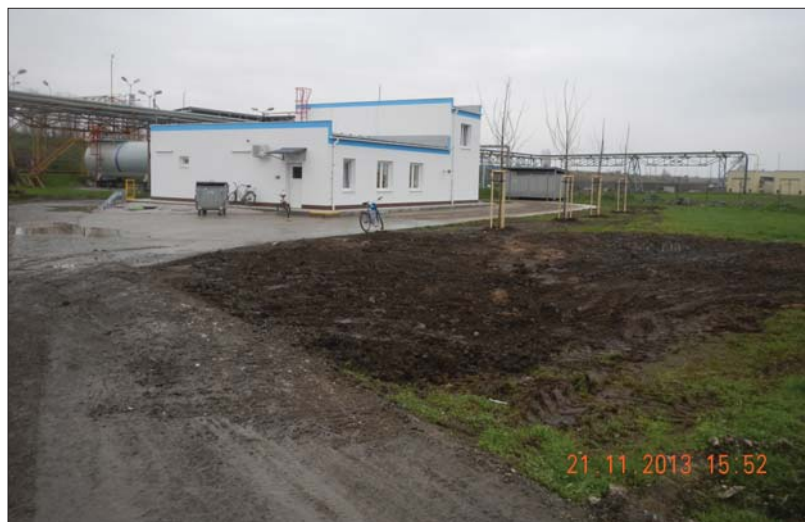
Nový velín a rozvodna.
