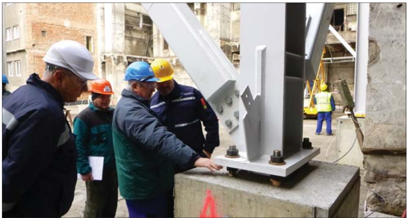
Inspekce na stavbě (zleva K. Patočka, A. Chytil, J. Frtůs a O. Pacholík).
