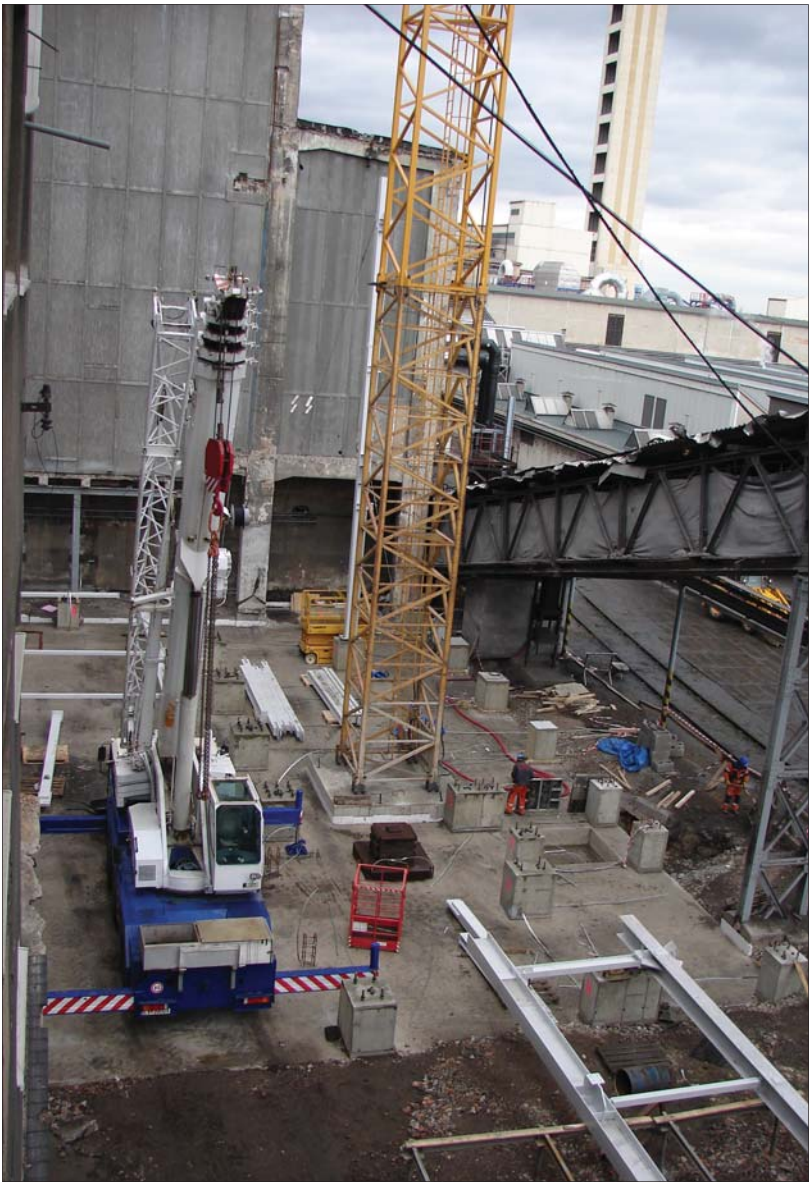
Zahájení instalace ocelové konstrukce.
