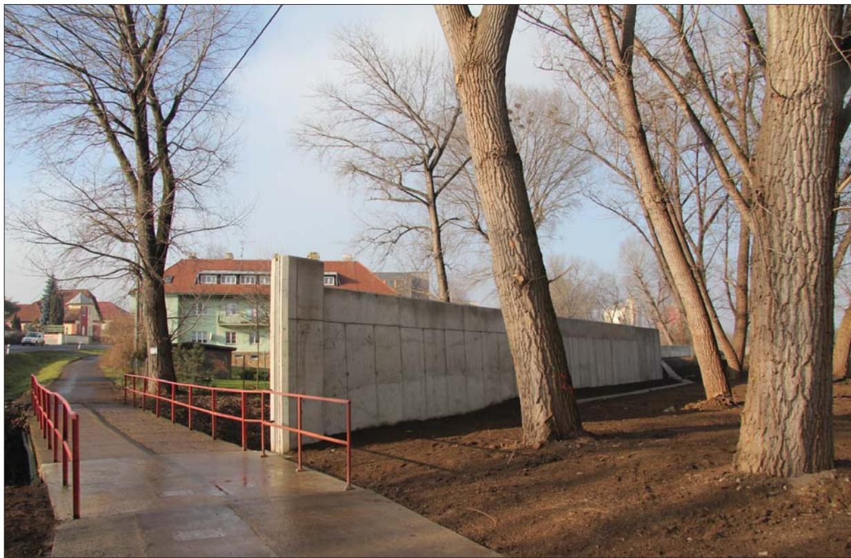
V prosinci byla dokončena poslední část protipovodňové ochrany.
