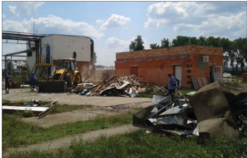
Demolice starého velínu.
