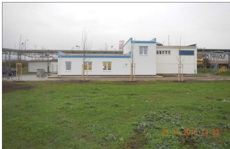
Nový velín a obě rozvodny.
