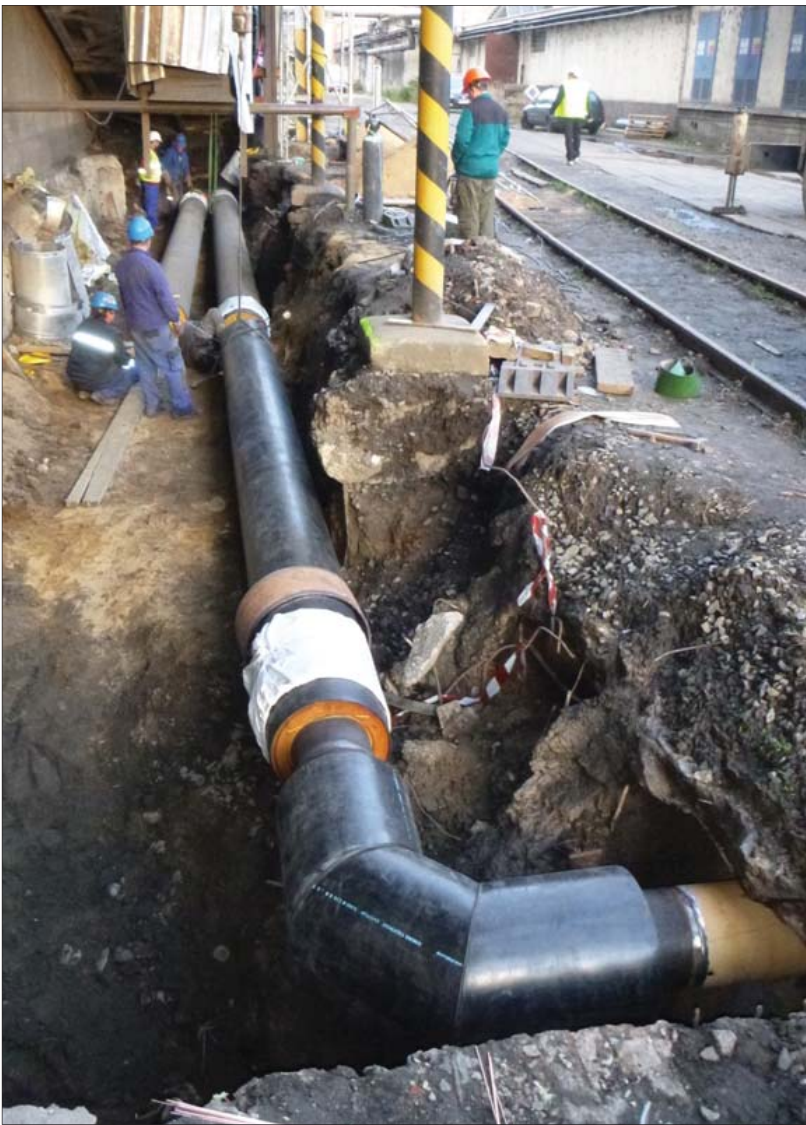
Montáž potrubí horkovodu. Foto: Václav Havlík
