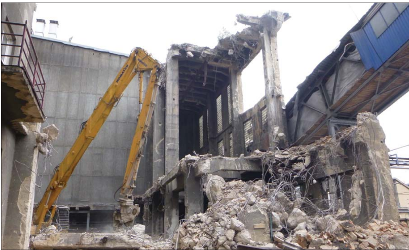
Likvidace roštové kotelny. Foto: Václav Havlík
