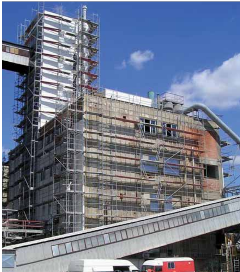
Stav prací - jižní fasáda - polovina srpna.
