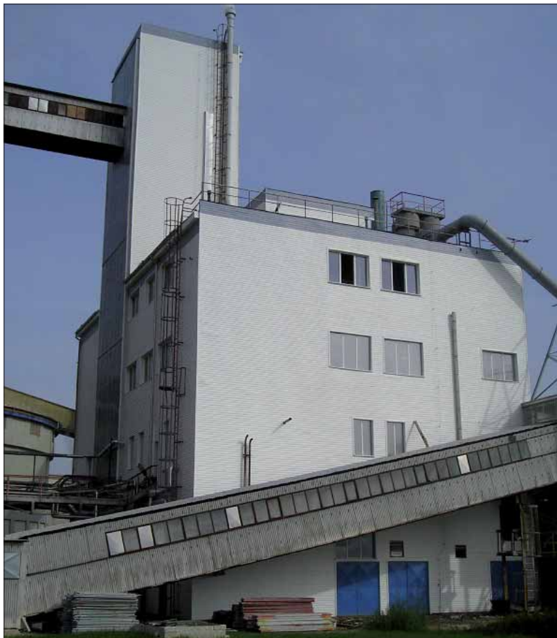
Dokončená oprava - pohled jihozápadní.
