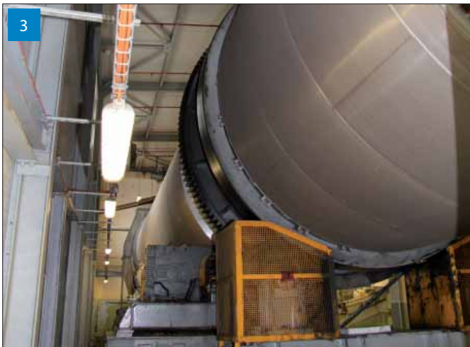
Kondicionér - Po vyčištění se řepkové semeno nahřívá na cca 80 °C pro další snadnější zpracování.
