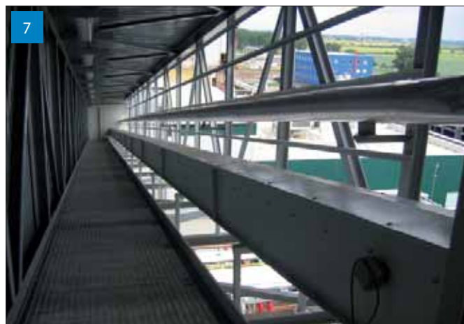
Dopravník vylisků mezi budovami lisovny a extrakce.
