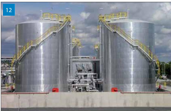
Uskladnění neutralizovaného polorafinovaného oleje v nádržích v atmosféře dusíku pro zachování kvality.
