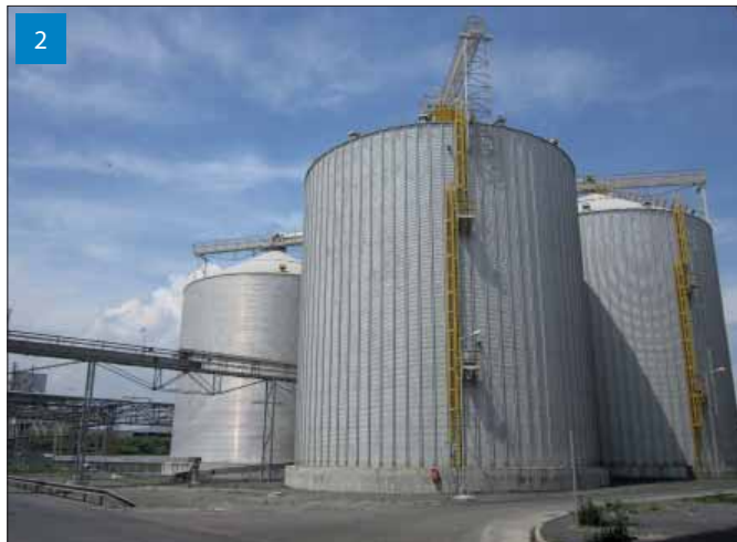
Řepkové semeno se uskládá ve dvou silech. Kapacita uskladnění řepky v PREOL je 11 tisíc tun, tedy zásoba suroviny na zhruba 9 dní provozu.
