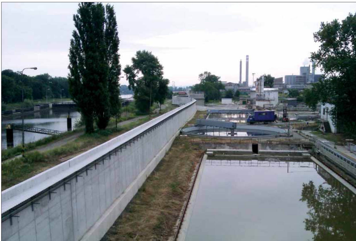
Protipovodňová stěna chrání ČOV před stoletou vodou.
