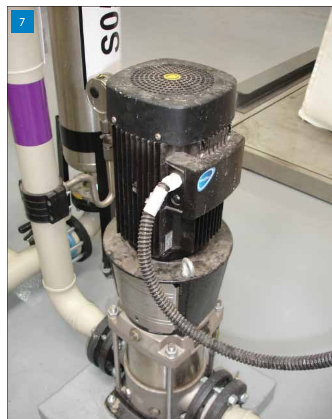
Expediční čerpadlo. Expeduje se do autocisteren nebo do IBC kontejnerů o objemu 1 000 l.
