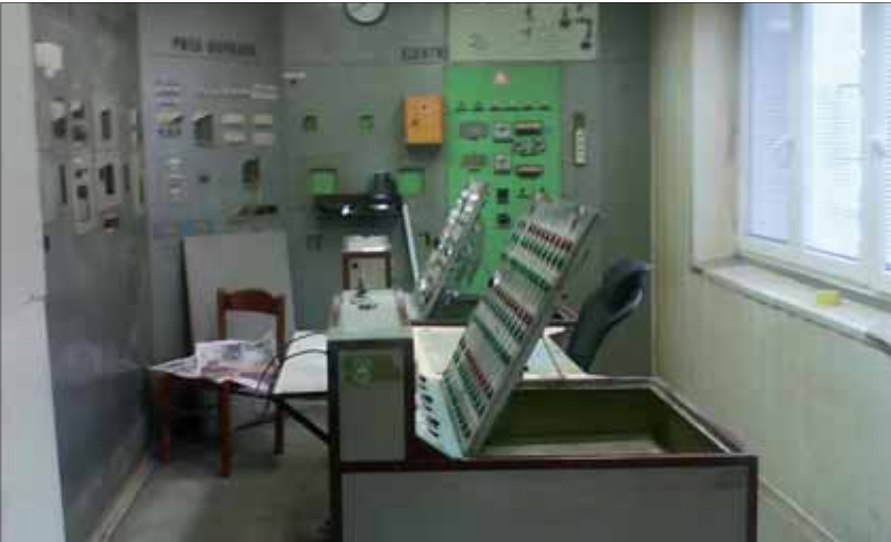
Velín před rekonstrukcí.
