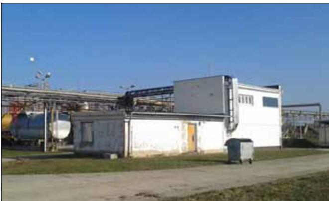
Místo před započetím prací 4. března 2013.
