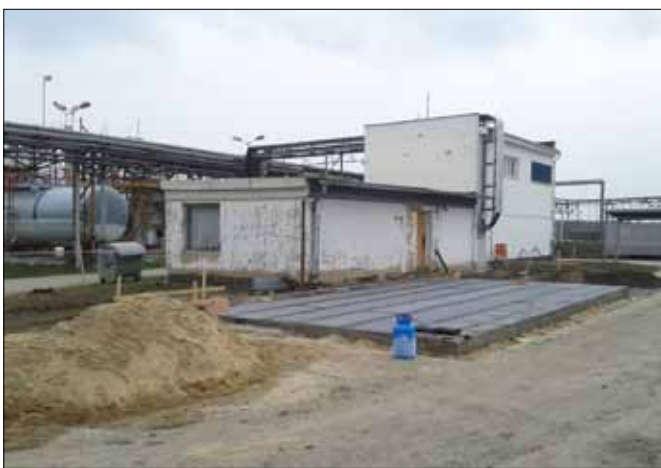
... hydroizolace základové desky a ...
