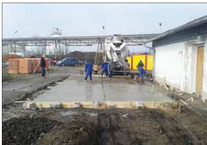
...betonáž základů a základové desky, ...
