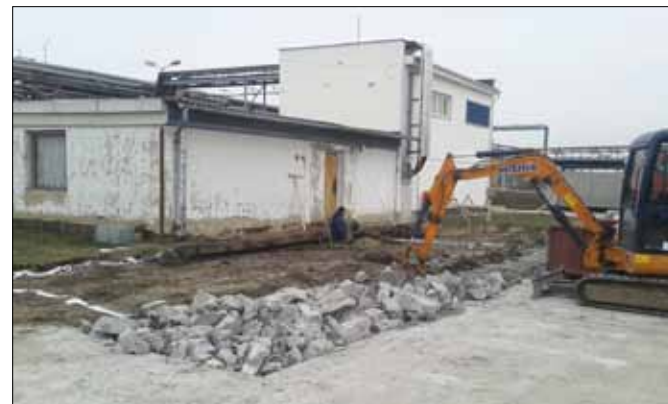
Následovala skryvka ornice a odstranění části vozovky, ...
