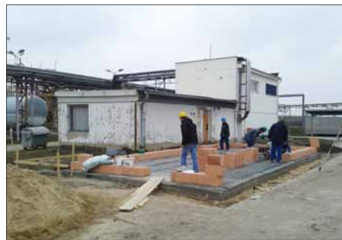
... zakládání první řady obvodového zdiva.
