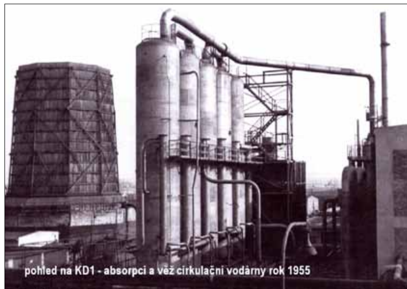
Pohled na absorpci a chladič věž KD1 v roce 1955
