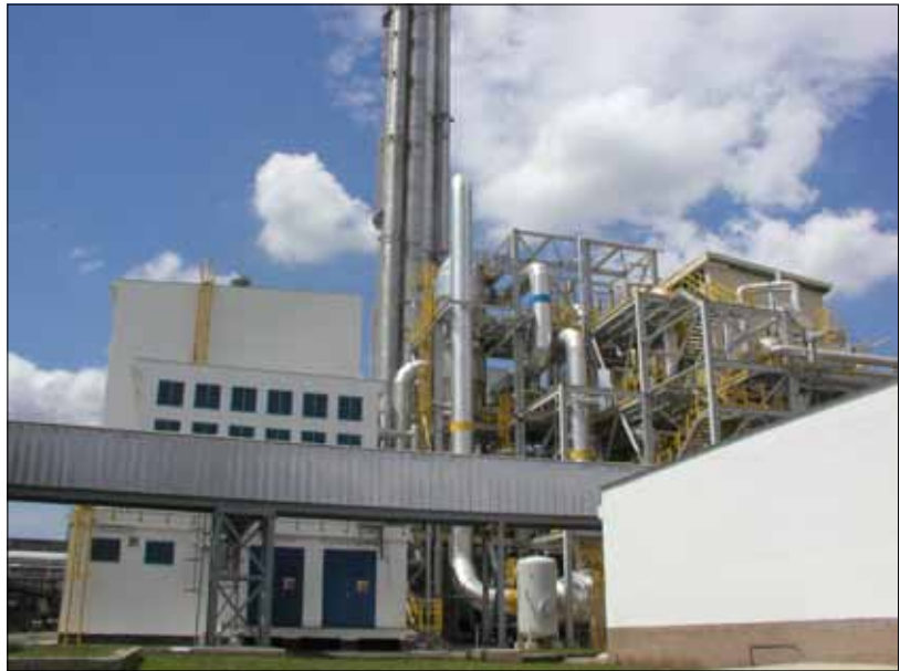
Výrobní KD6 - pohled z východu.
