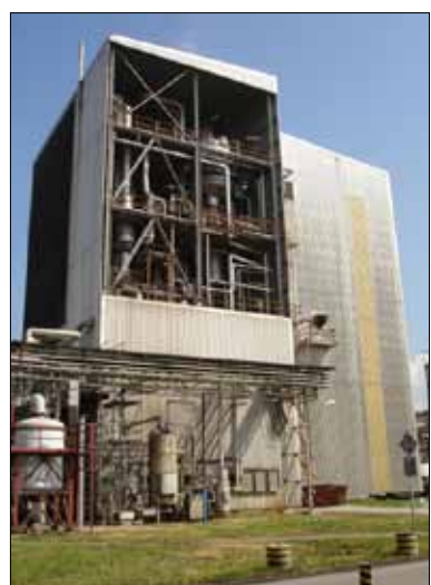
Výroba LAV3, kde bylo dosaženo rekordu. Zdroj: Archiv Lovochemie
