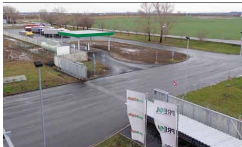
Hotová čerpací stanice po měsíci a půl.
