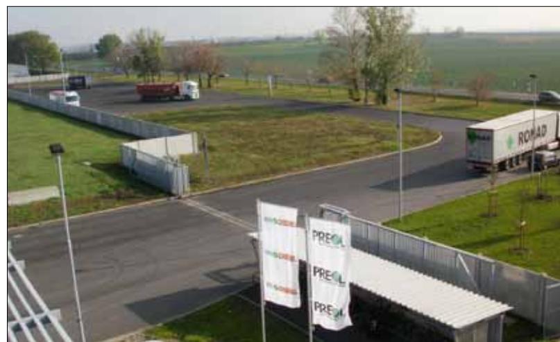
Plocha před předáním staveniště 5. 11. 2012.
