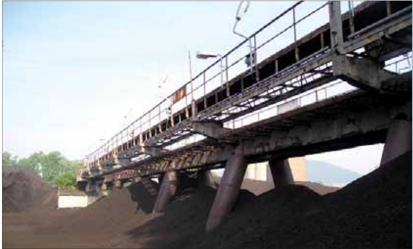
Stav před opravou.
