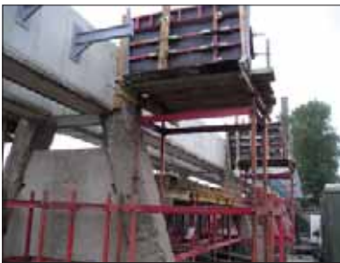
Dokončená železobetonová obálka + sanace konzol. Foto: Miroslav Kraut
