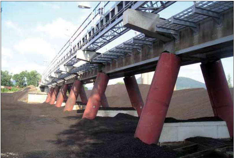
Dokončená oprava stavebního díla mostu. Foto: Miroslav Kraut
