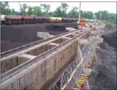
Příprava železobetonové obálky. Foto: Miroslav Kraut
