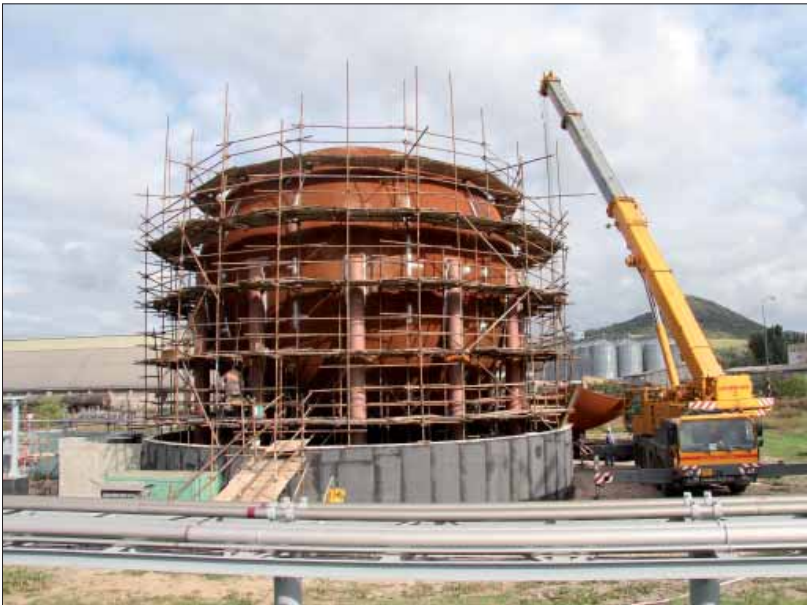
V rámci investiční akce „Obnova kulových zásobníků amoniaku A+B“ probíhají dokončovací práce na montáži pláště kulového zásobníku A. Uvedení do zkušebního provozu celé technologie zásobníku A se předpokládá do konce listopadu 2012. Realizaci zajišťuje firma Vítkovice VPE a.s. Foto: Eva Živná
