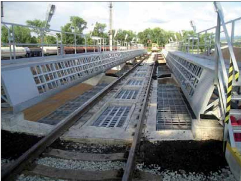
Dokončená oprava ocelových konstrukcí výklopníku + osvětlení. Foto: Miroslav Kraut
