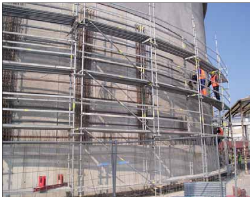
Průběh prací při opravě vnějších stěn kruhového skladu NPK. Foto: Miroslav Kraut
