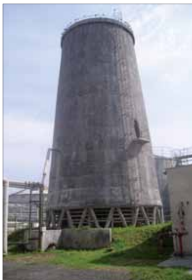
Chladicí věž NPK určená k demolicí. Foto: Miroslav Kraut
