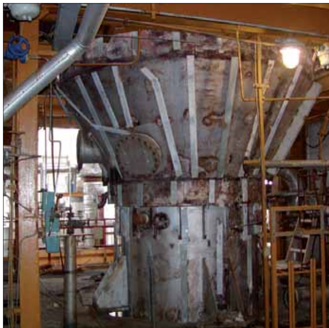
Ze starého kotle byla odstraněna izolace.
