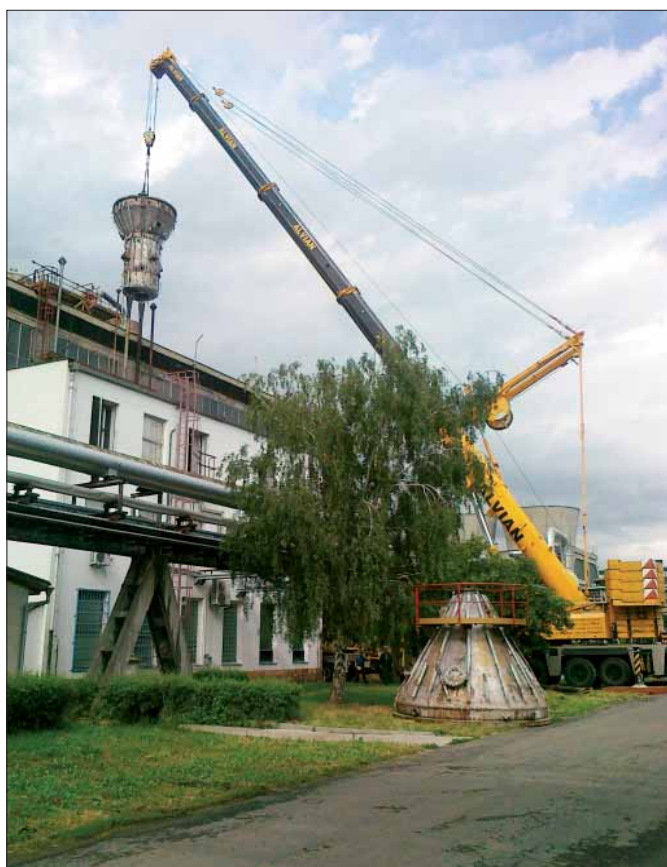
Vedle budovy stál obrovský jeřáb, který kotel zvedal.
