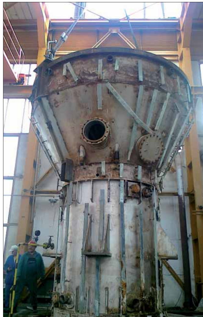
Pak byl kotel opatrně vyzvednut připraveným otvorem ve střeše budovy.
