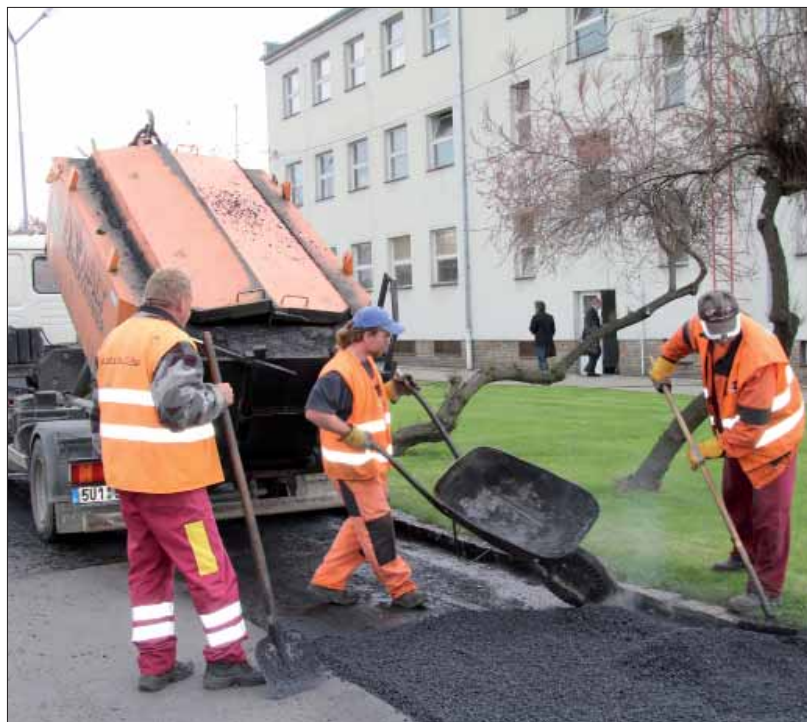
V květnu byly zahájeny opravy výtlučků asfaltových komunikací v areálu Lovochemie.
