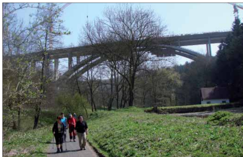
Putování pod rozestavěným dálničním mostem.
