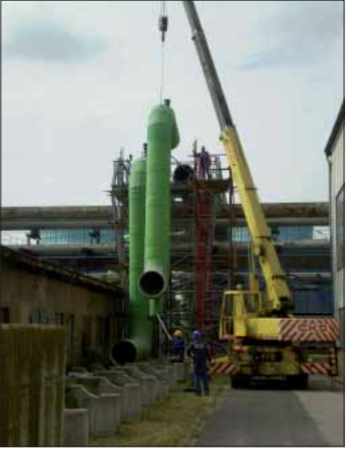
Během loňského roku byla provedena oprava potrubí chladicí vody pro KD6. Foto: Antonín Galle
