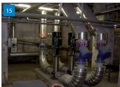
Oběhová čerpadla horkovodu
