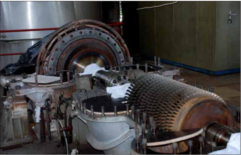
Turbosoustrojí KD5 při ložské celozávodní zarážce. Foto: Luděk Jambor
