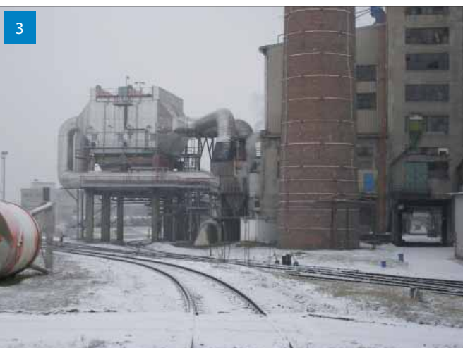
Uhelová kotelná a odlučovače popílku
