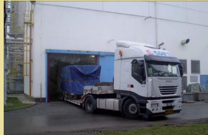
Spodní skříň kompresoru přijela 10. listopadu a byla vyložena přímo do kompresorovny.
