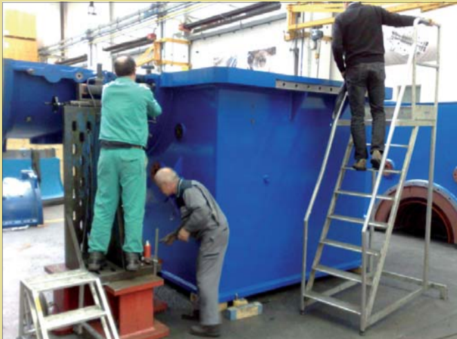
Oprava skříně kompresoru ve Schiu (Itálie).
