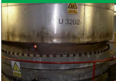
6. reaktor na oxidaci vzduchočpavkové směsi
