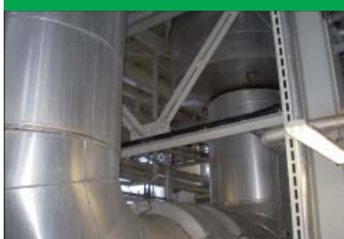
11. spodní část reaktoru selektivní redukce
