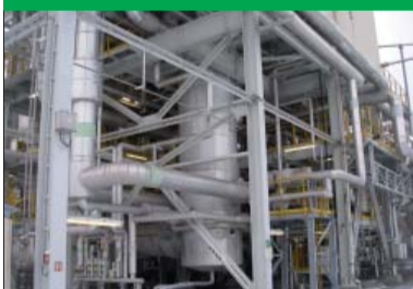
7. kotel na odpadní teplo
