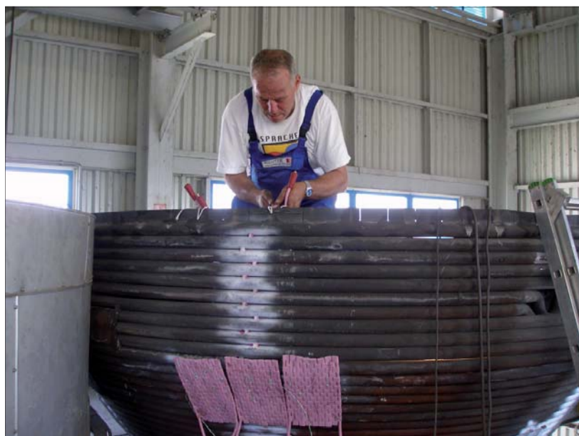
Práce na přehříváku kotle KD6.
