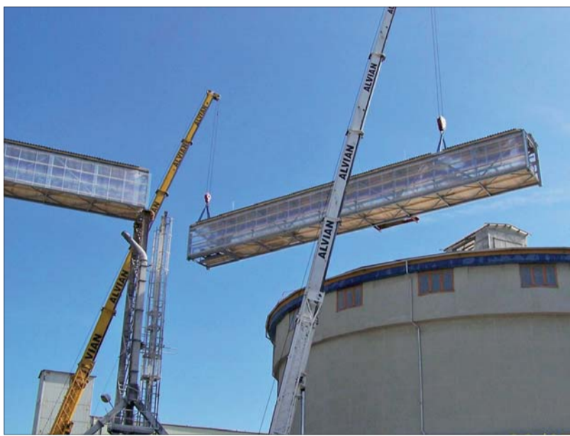
Montáž dopravního mostu na expedici LV pomocí dvou jeřábů. Foto: Milan Jackov
